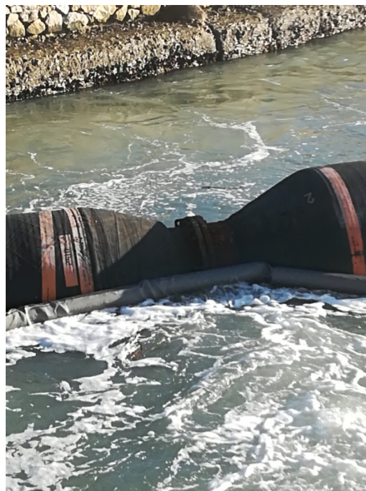
Dettaglio delle panne: l'acqua in uscita dalla vasca trovata un varco nel punto in cui la tubatura con cui viene trasferito il materiale dragato incontra le panne.
