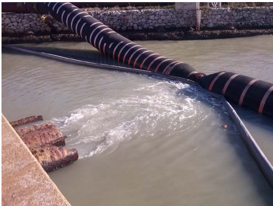
Uscita delle acque di sfioro dalla Darsena Petroli
