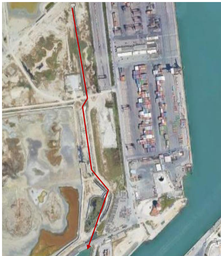
Figura 15 Canale di drenaggio esistente presso la vasca di colmata
