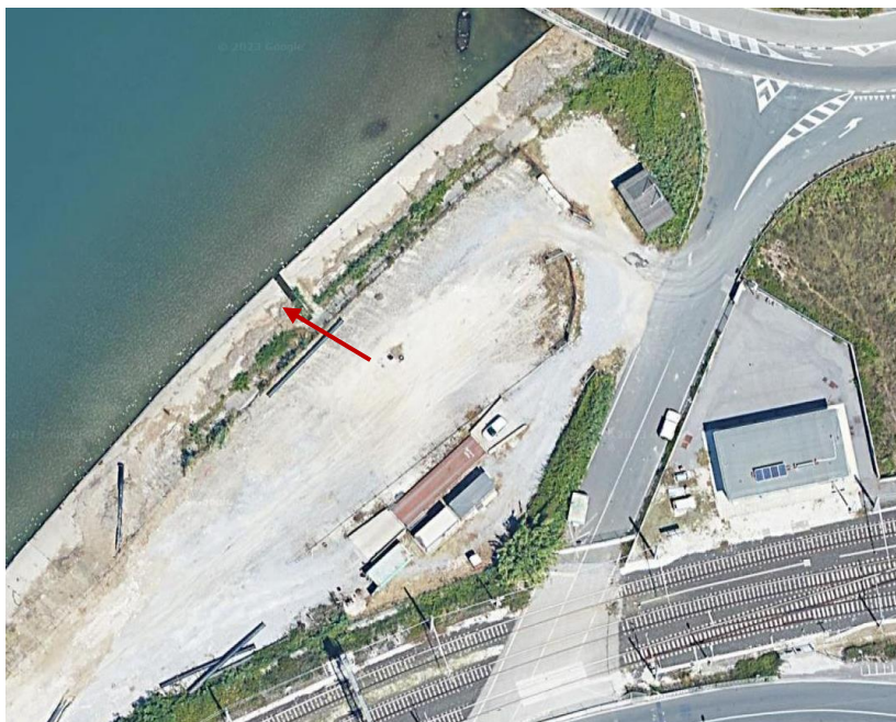
Figura 13 Tubazione di scarico acque meteoriche esistente presso cantiere principale
