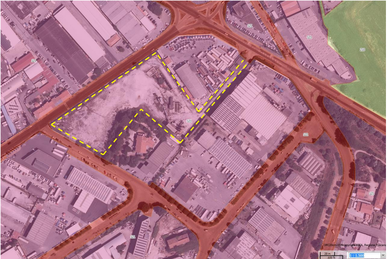
Figura 15: uso del suolo cantiere Piano di Rota (fonte: geoscopio Regione Toscana)
