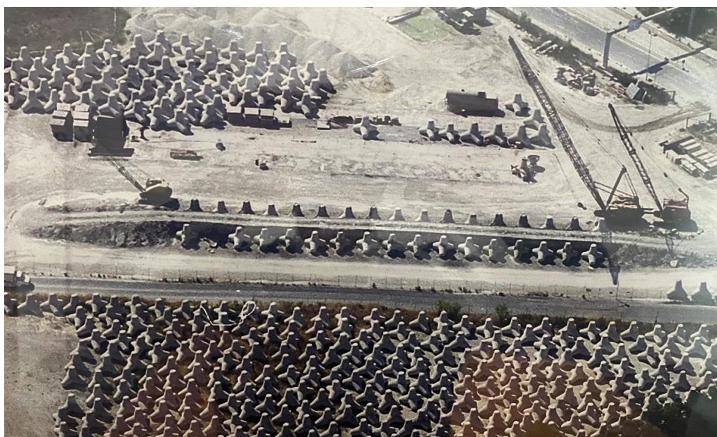
Figura 11: foto tipologia dell'ambito di prefabbricazione accropodi.
