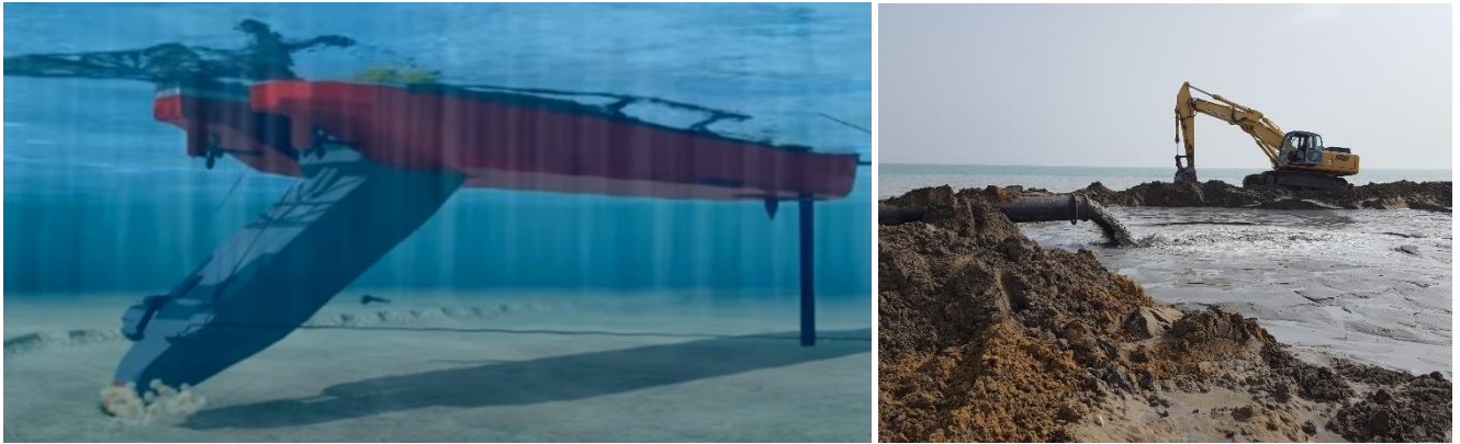
Figura 4.1 - Scavo con draga CSD (courtesy of Jan de Nul n.v.).
