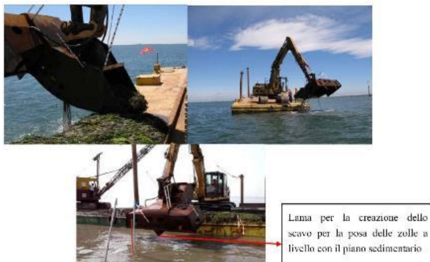
Figura 3.8 - Benna idraulica appositamente realizzata per il prelievo di grandi zolle
