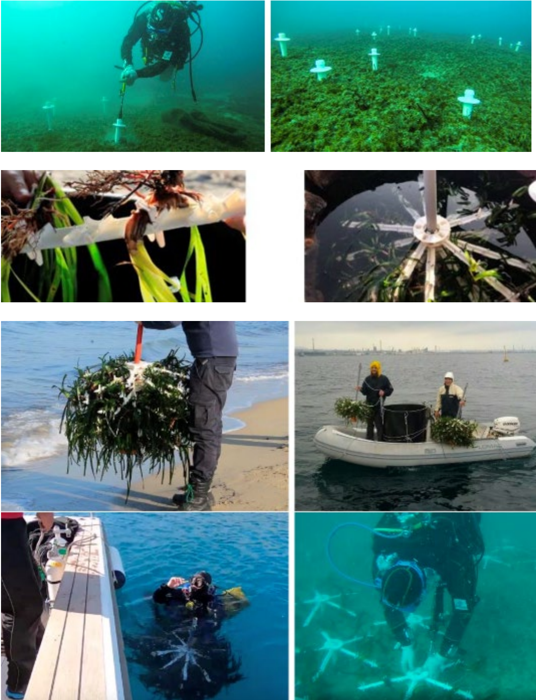
Fig.16: Fasi di processo trapianto di Posidonia
