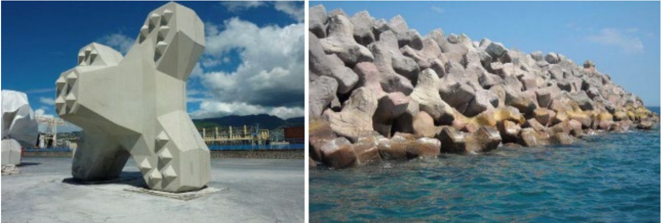
Fig.4: Mantellata single-layer in massi artificiali tipo Ecopode TM (dx, parti emerse) e tipo Accropode TM (sx, parti sommerse)
