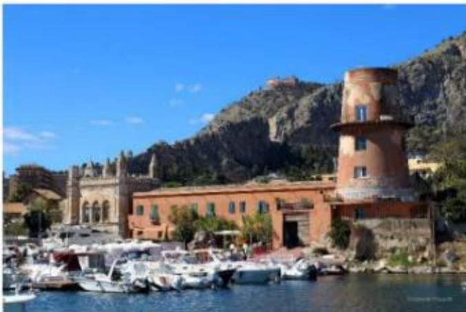
Figura 4-31: L'edificio della ex tonnara Florio e l'iconica "Palazzina dei Quattro Pizzi"
