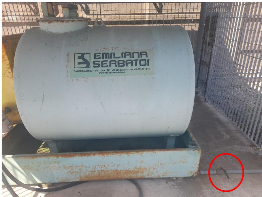
Figura 1: valvola di dreno del bacino di contenimento del serbatoio contenente gasolio, in posizione di chiusura.
