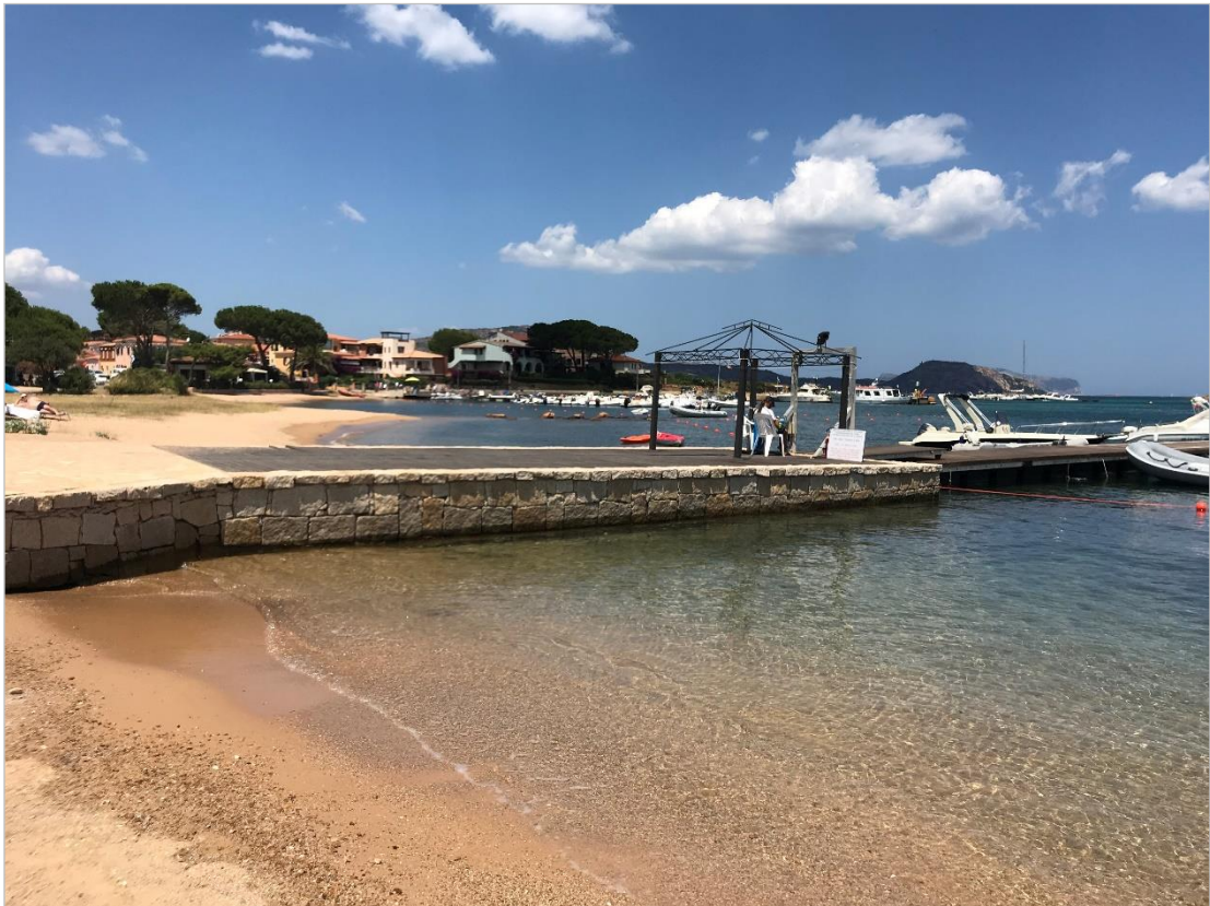
Stato attuale: vista dalla riva verso future nuove opere
