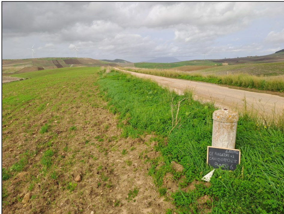
Fig. 31: Cavidotto esterno. Punto 6 – Tratto I
