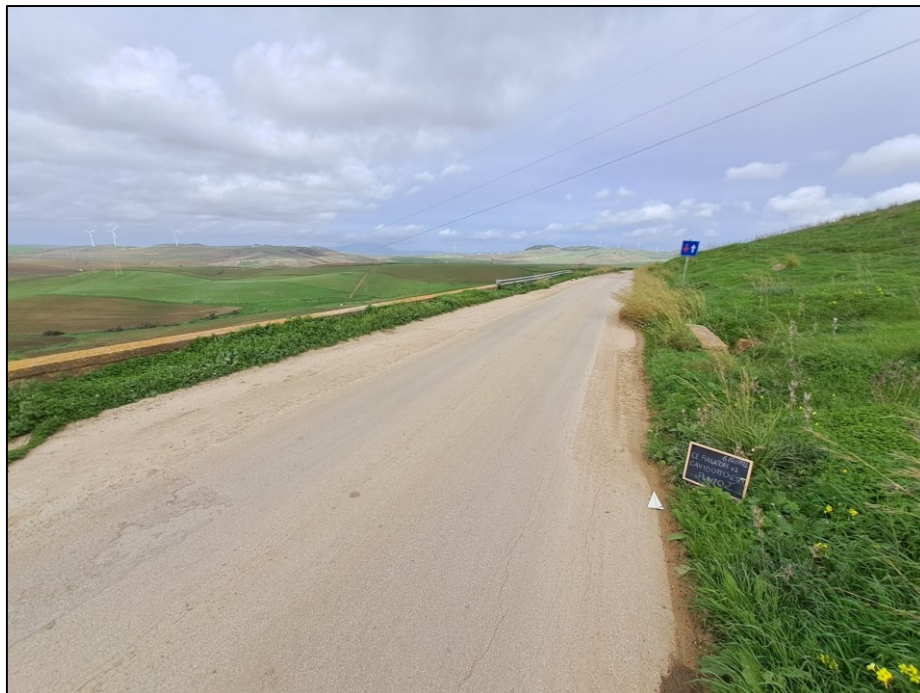
Fig. 27: Cavidotto esterno. Punto 2 – Tratto I
