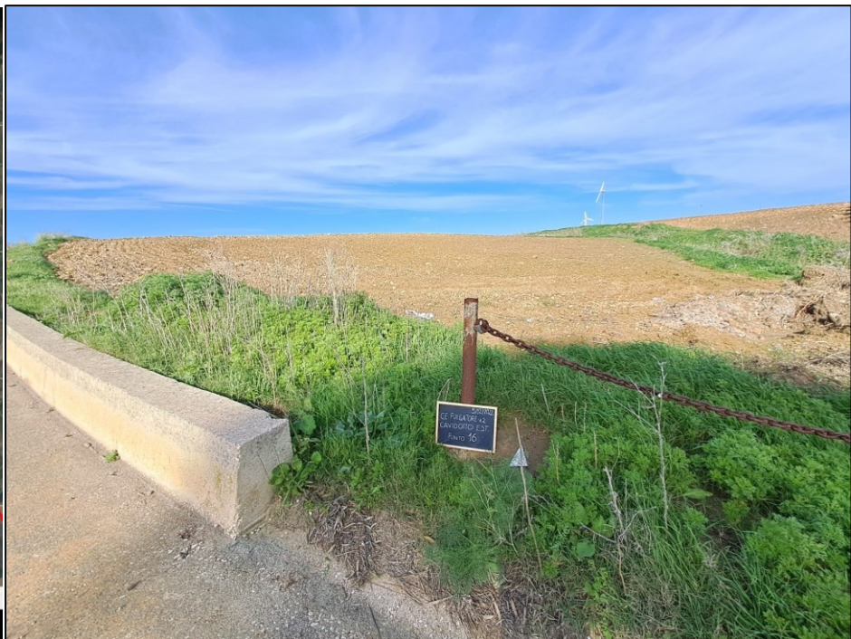
Fig. 44: Cavidotto esterno. Punto 16 – Tratto VI
