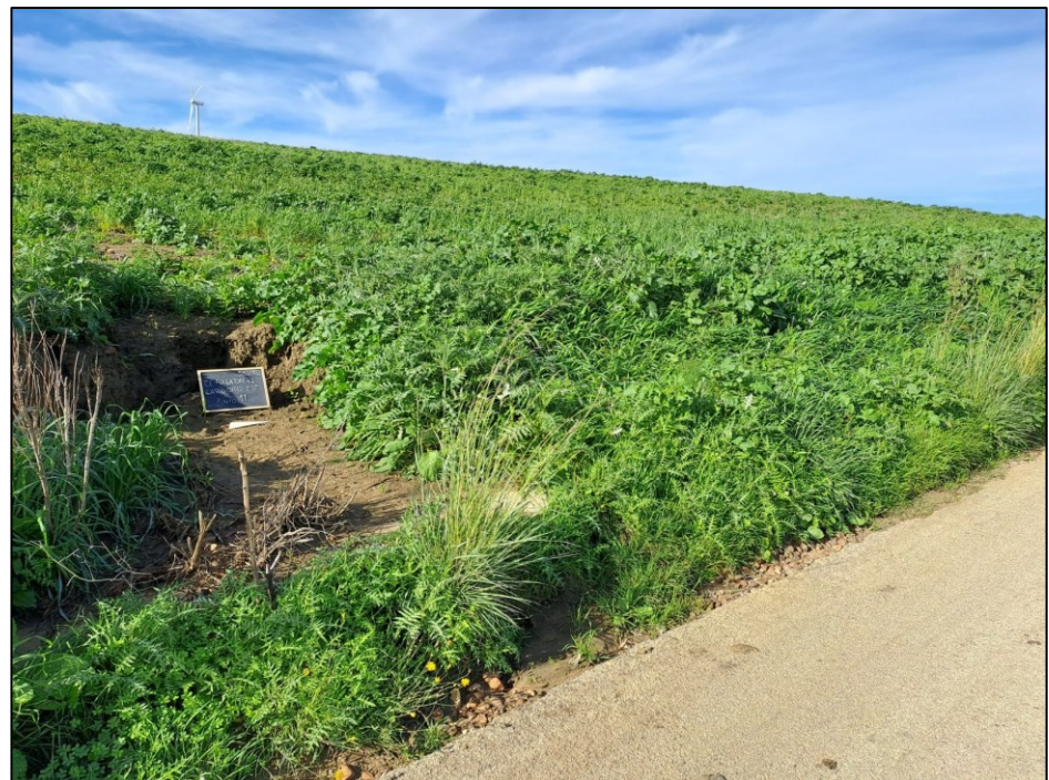
Fig. 37: Cavidotto esterno. Punto 11 – Tratto II
