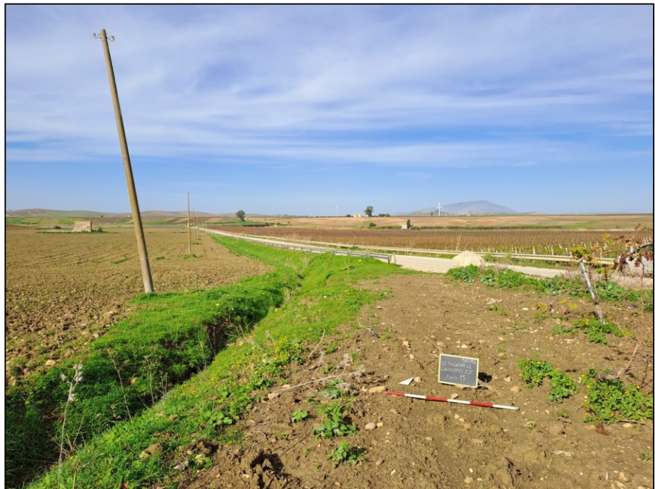
Fig. 43: Cavidotto esterno. Punto 15 – Tratto V
