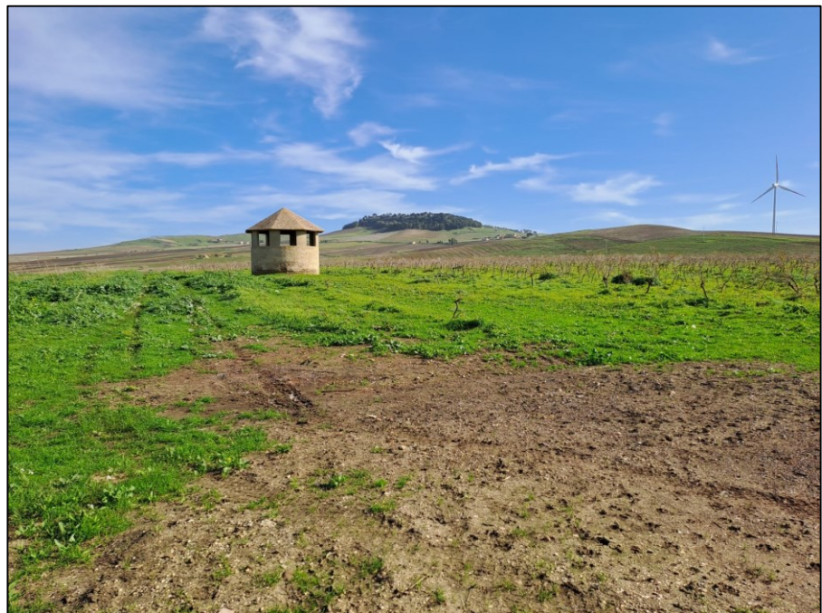
Fig. 41: Cavidotto esterno. Punto 13 – Tratto IV
