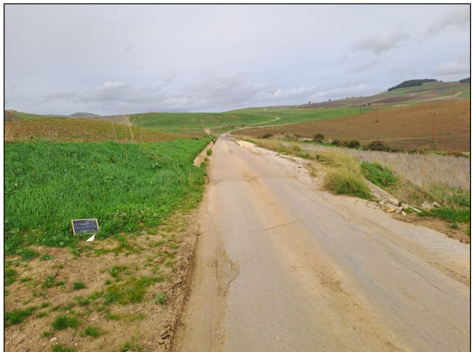
Fig. 33: Cavidotto esterno. Punto 8 – Tratto II
