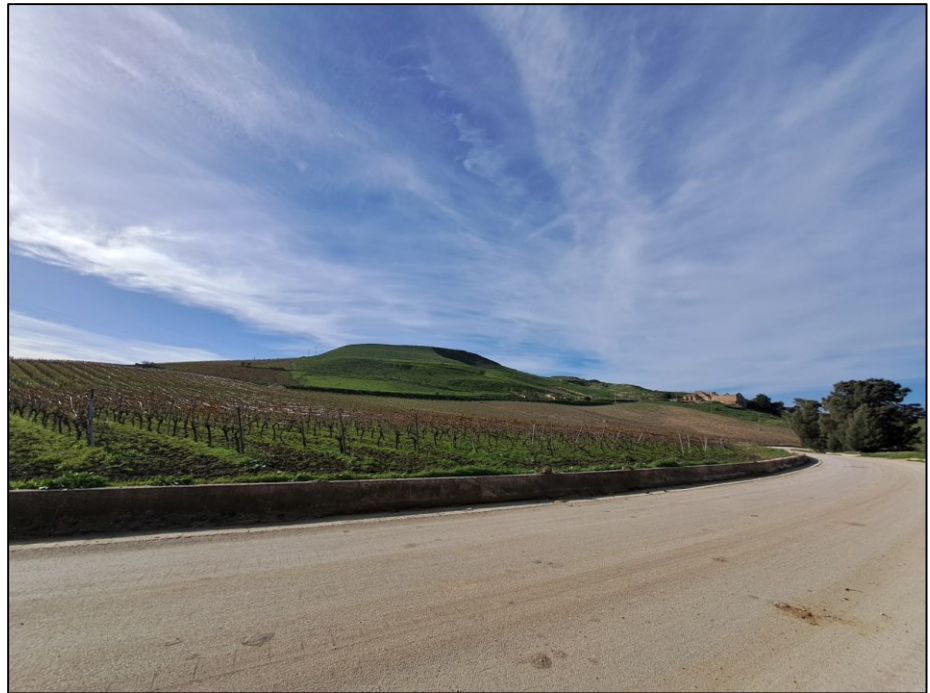
Fig. 42: Cavidotto esterno. Punto 14 – Tratto IV
