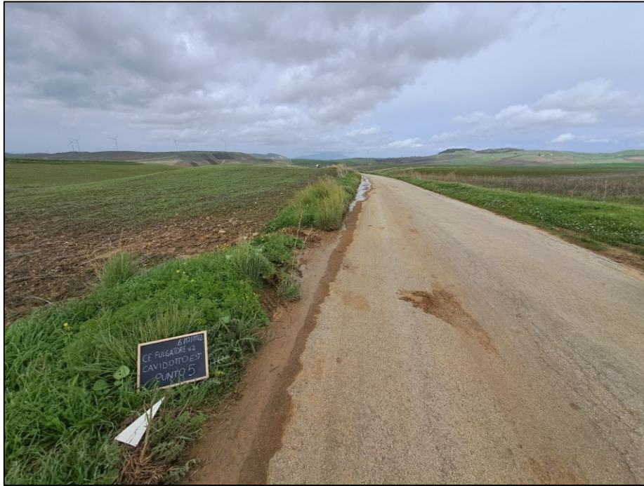
Fig. 30: Cavidotto esterno. Punto 5 – Tratto I
