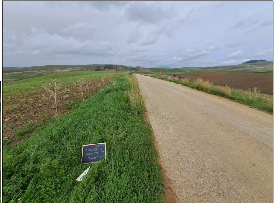
Fig. 32: Cavidotto esterno. Punto 7 – Tratto II
