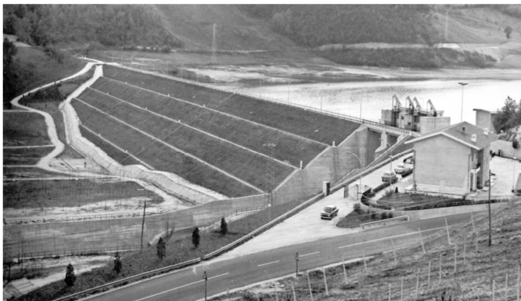
Figura 7: Diga di Polverina - vista da valle
