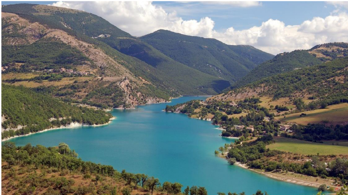
Figura 15: Serbatoio del Fiastrone – vista aerea
