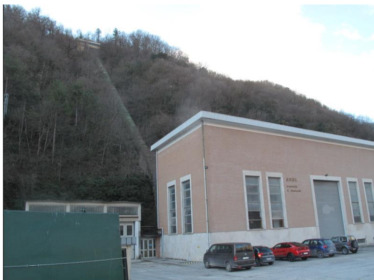
Figura 4: Vista della centrale e della condotta della derivazione Chienti (bacino di Polverina)
