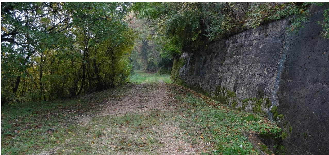
Figura 81: Accesso cantieri in quota – Strada di accesso alla camera valvole Polverina
