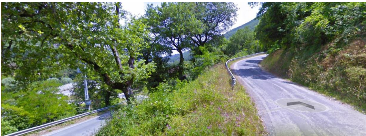
Figura 79: Accesso cantieri in quota – strada secondaria asfaltata (credits: Google)
