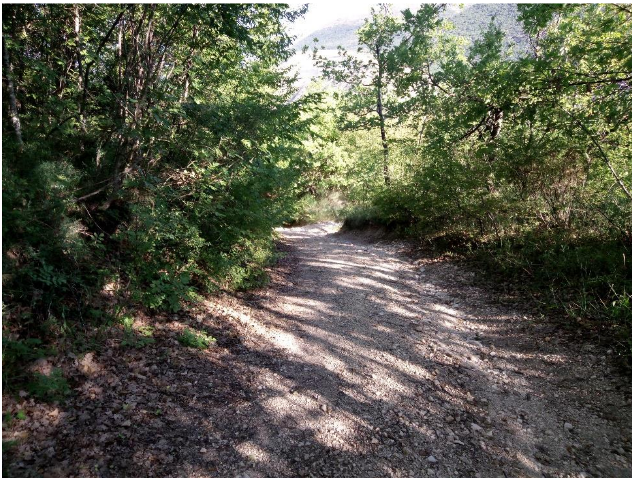
Figura 86: esempio strada esistente con fondo naturale. Il fondo appare irregolare con rami laterali che riducono localmente la sezione utile
