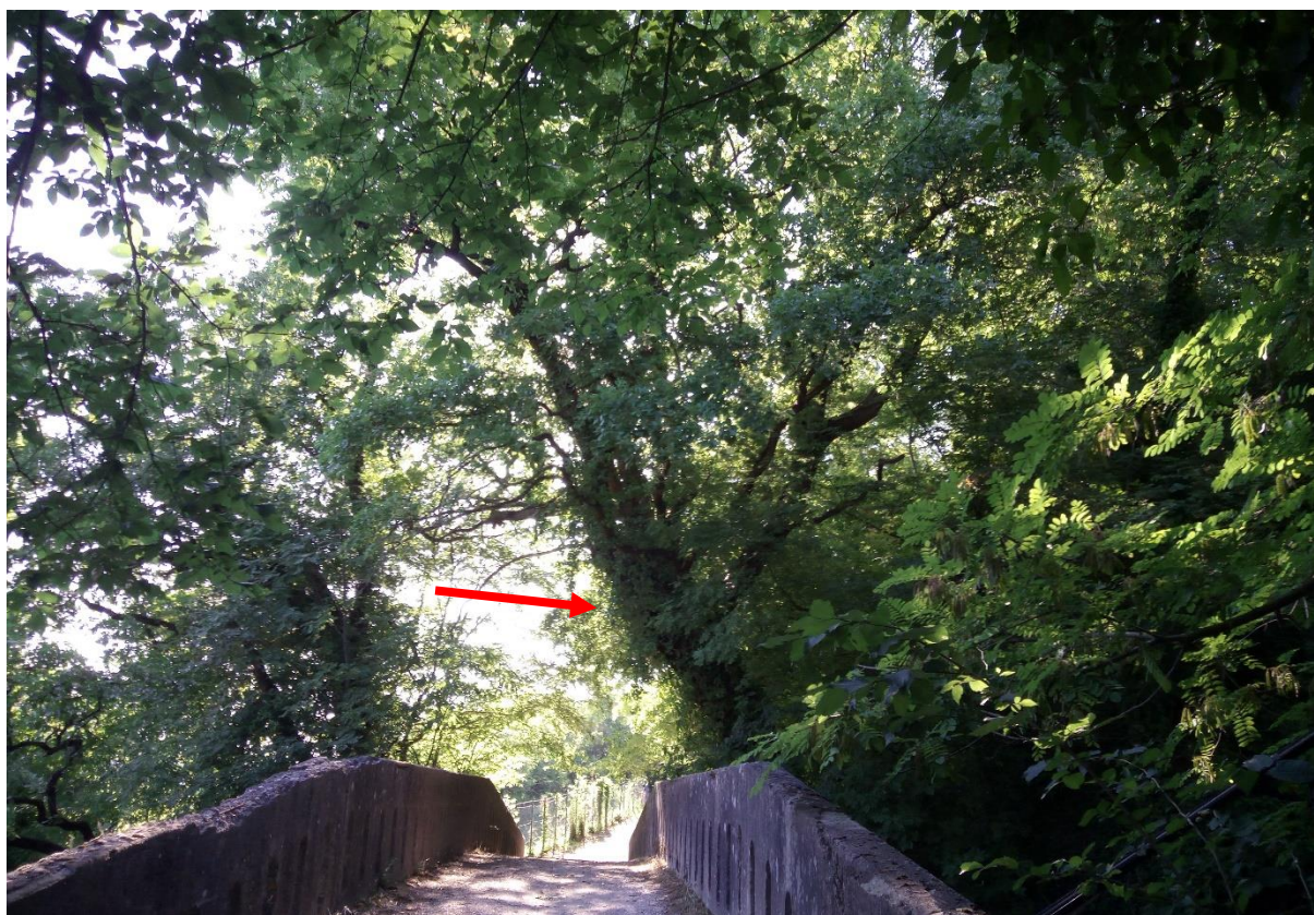
Figura 88: soggetto quercino interessato dai lavori
