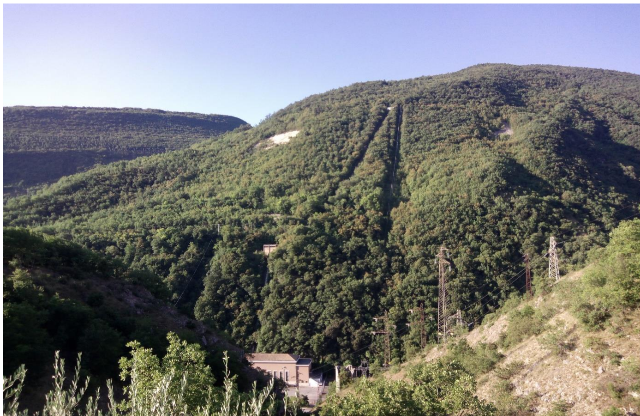
Figura 49: vista del versante del Monte Fiungo oggetto di intervento
