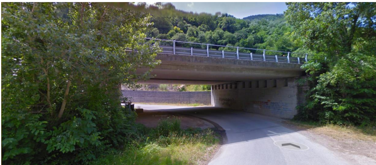
Figura 77: Accesso cantieri in quota – sottopasso S77var (credits: Google)
