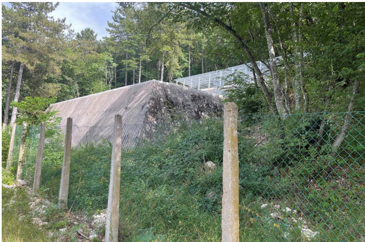
Figura 105: Vasca di espansione esistente - area di lavoro estensione pozzo piezometrico Fiastrone
