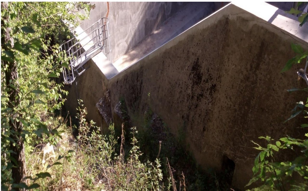
Figura 93: vasca di espansione da demolire
