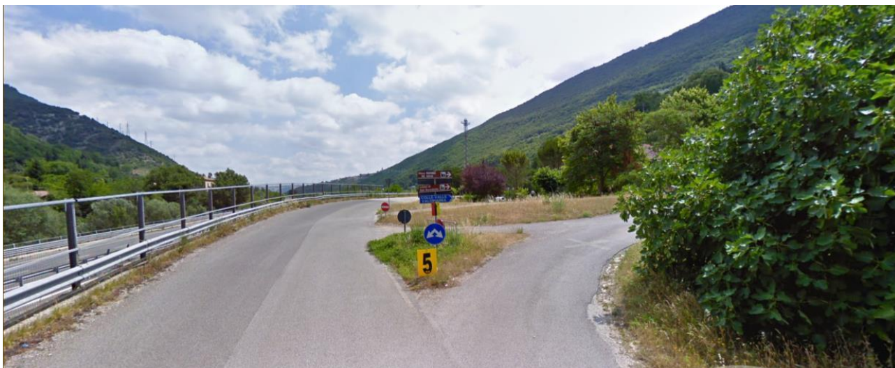
Figura 78: Accesso cantieri in quota – Svincolo verso Madonna del Sasso (credits: Google)
