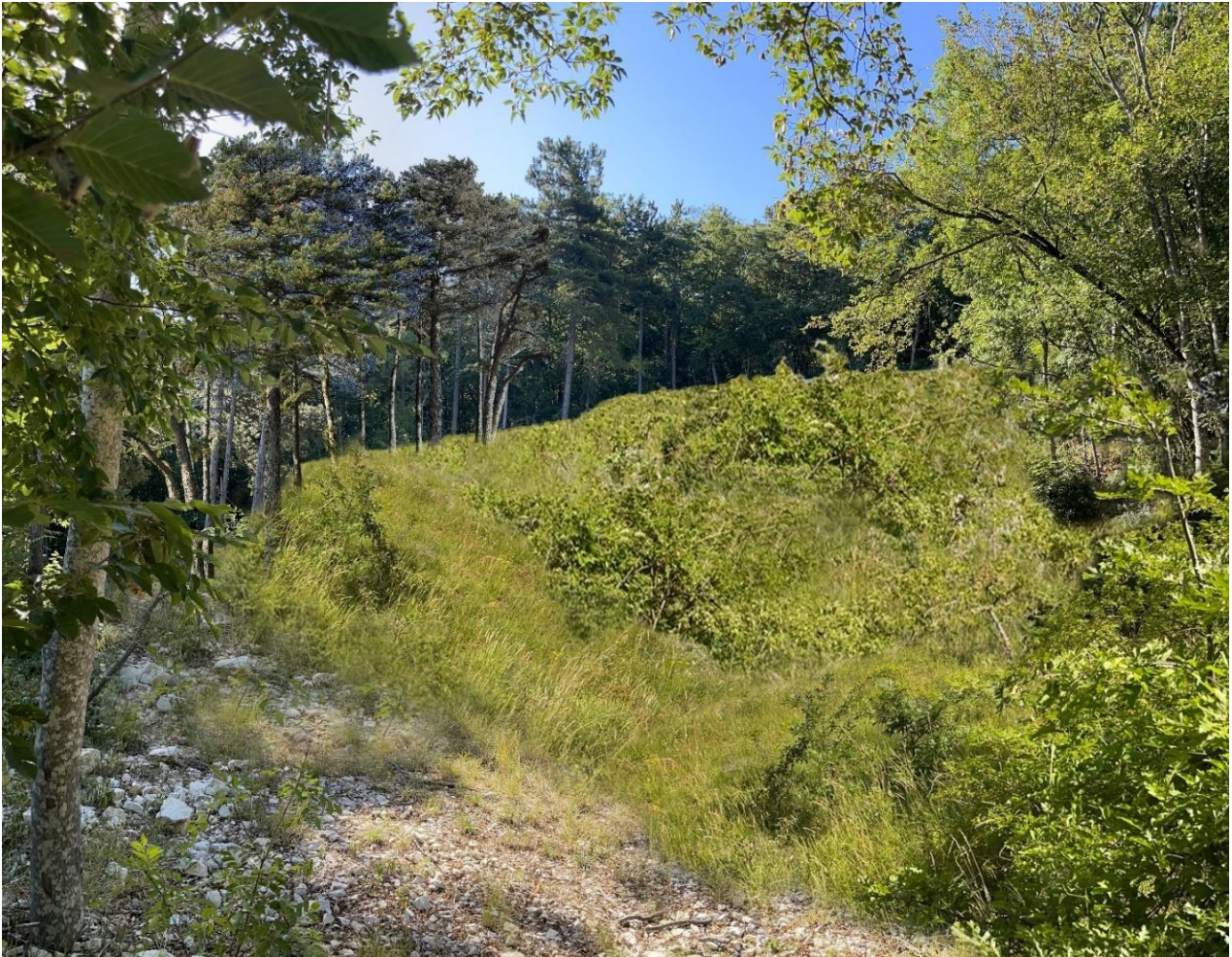
Figura 106: fotosimulazione a seguito dei lavori estensione pozzo piezometrico Fiastrone
