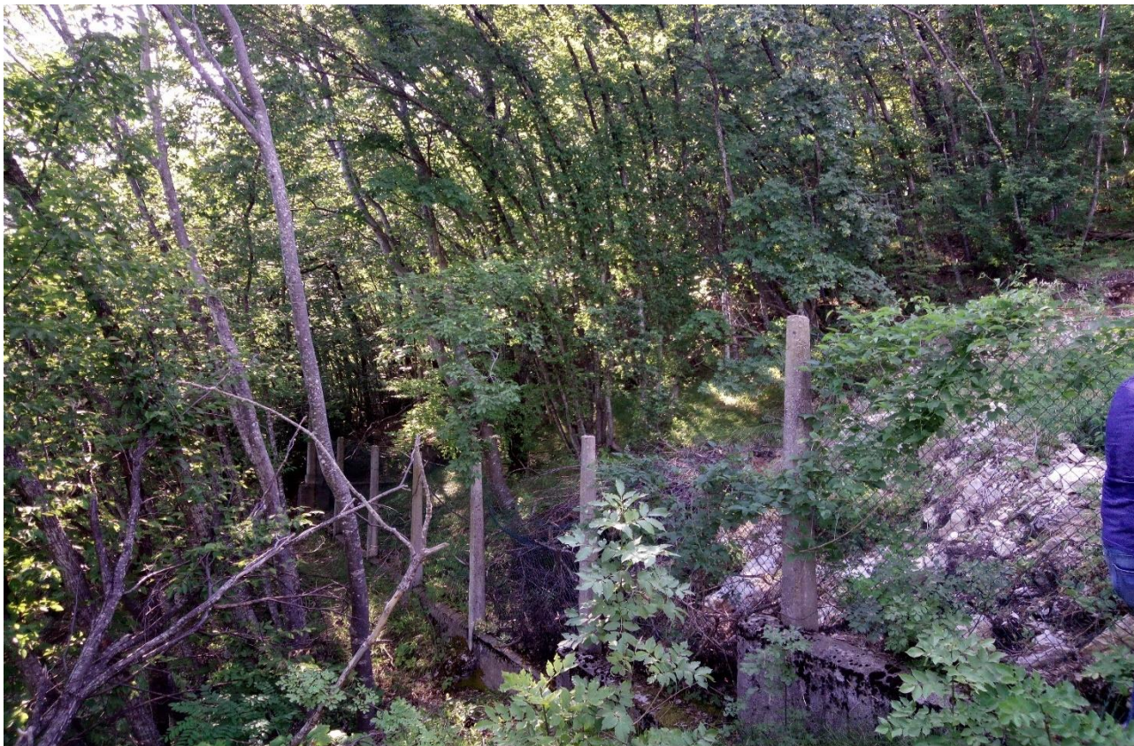
Figura 92: vegetazione sul lato ovest della vasca di espansione da demolire
