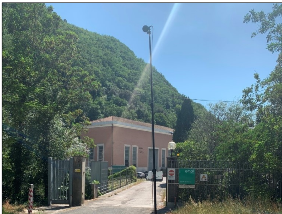
Figura 18: postazione VC-5, rappresentativo del rumore ante operam nella futura area di cantiere
