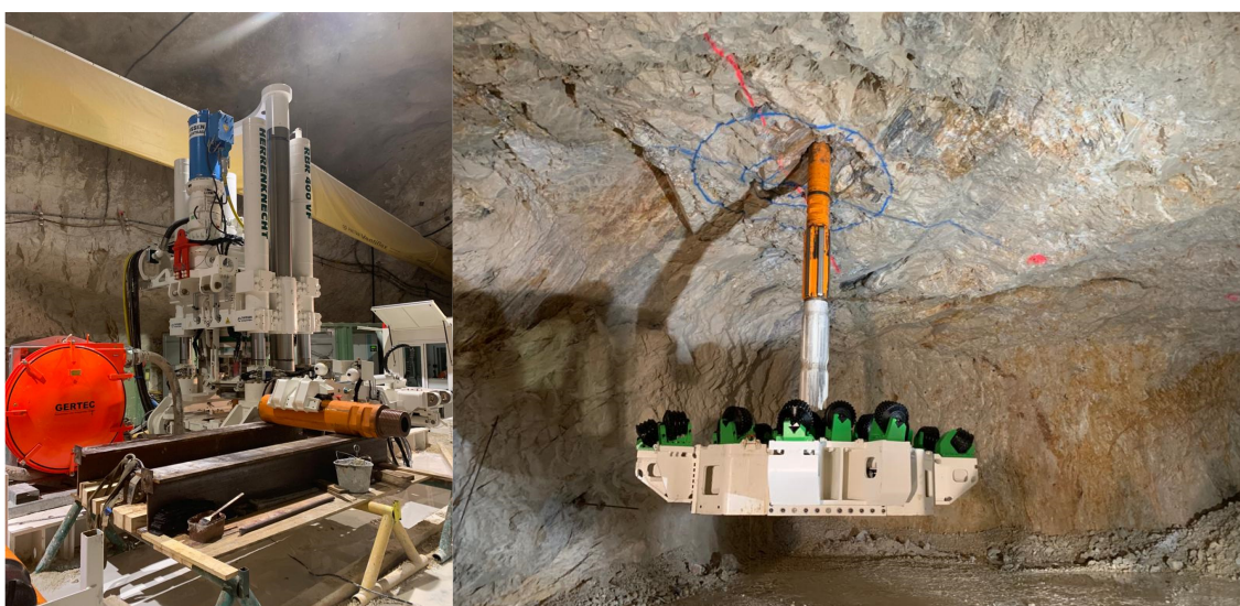
Figura 3: Impianto di Valcimarra Chienti - Parti dell'attrezzatura per il raise boring: a sinistra la macchina superiore per la rotazione ed il sollevamento, a destra la testa fresante, pronta per la fase di scavo.
