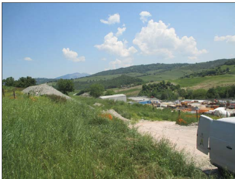
Cantiere Base località Piano dell'Abate VII C.O. maggio 2023
