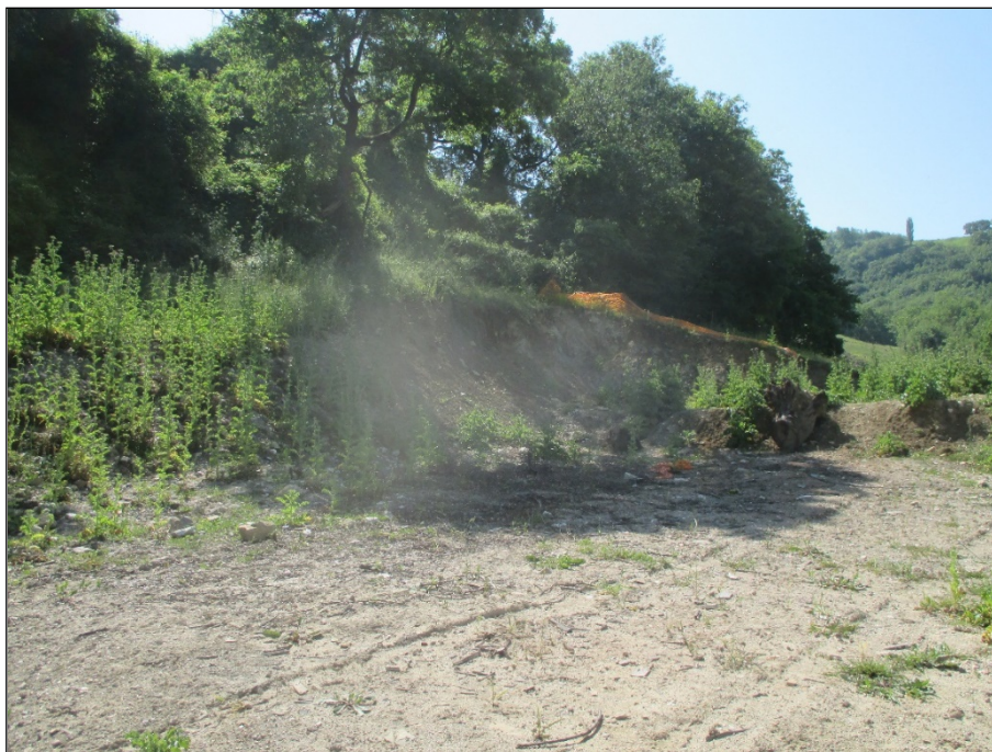
Particolare stazione di monitoraggio suolo SUOLO_01. Area cantiere viadotto "Tre Vescovi" VII campagna C.O. maggio 2023
