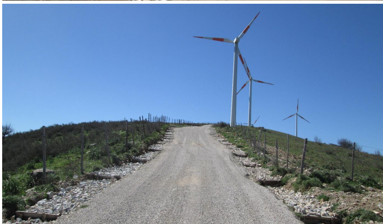
Figura 3: Sistema di fossi di guardia con fondo rivestito in pietrame e briglie.
