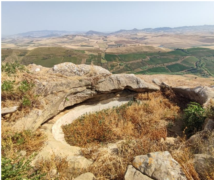
Img. 2 – Azione distruttiva della vegetazione infestante all'interno della cisterna.
