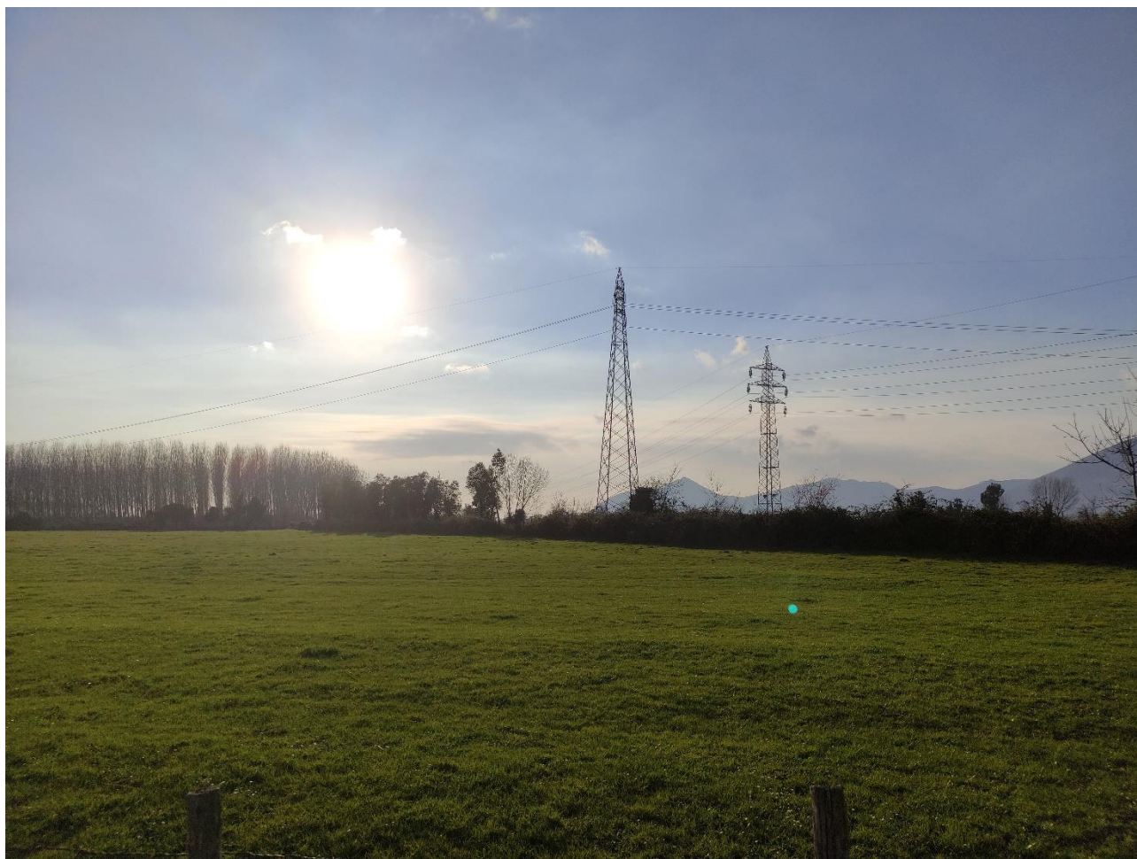
Figura 2.1 Fotografia verso l'area (attualmente a pascolo) identificata per la stazione 150kV nel comune Falciano del Massico. In evidenza il traliccio p.25 da smantellare e la linea doppia terna, in sottopasso alla linea 150kV "Carinola-Castelvoturno"
