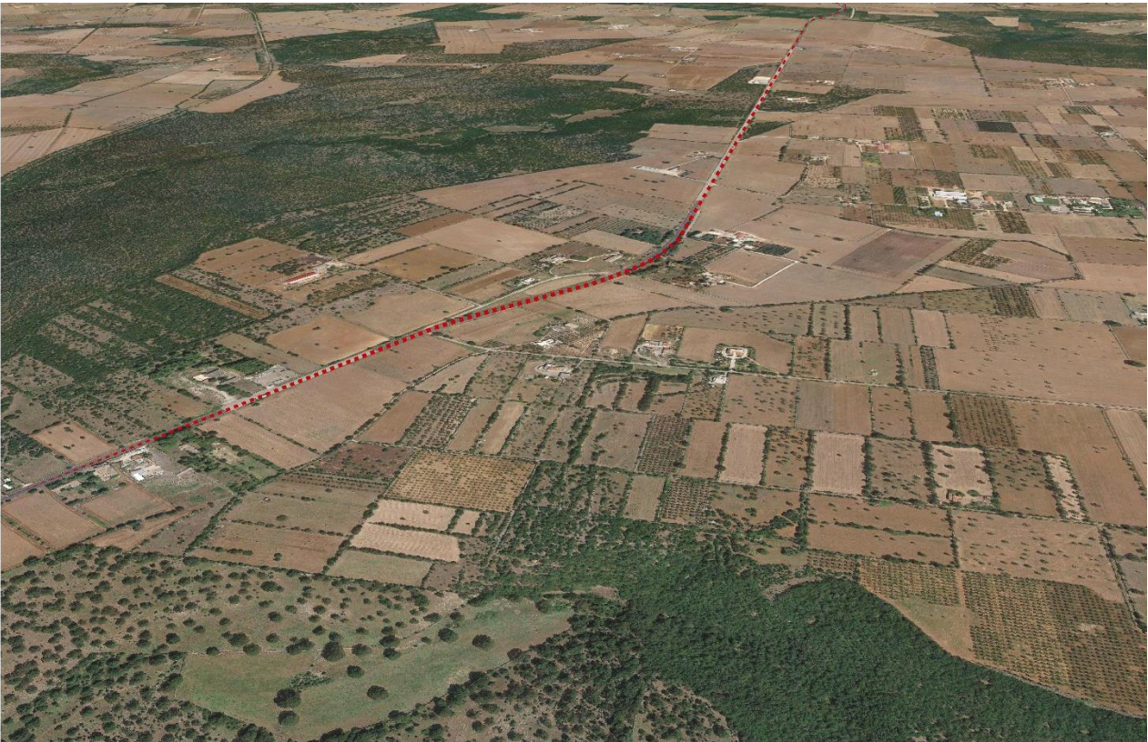
Figura 2-3 Vista aerea contesto territoriale in cui è inserita la Strada Statale 100 (SS100)
