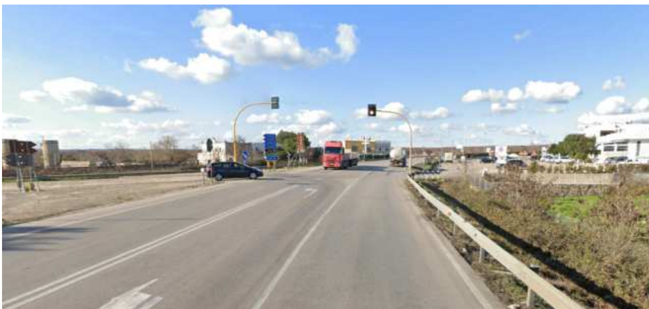
Foto 2: Fine intervento km 52+600 località San Basilio (fonte google map)
