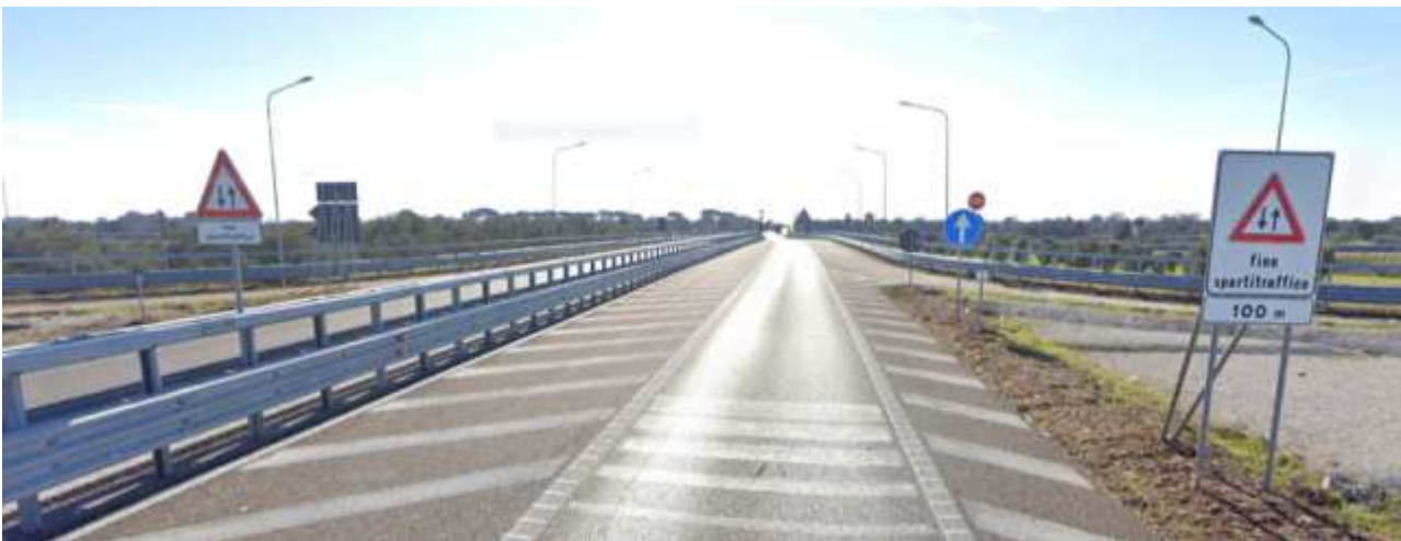
Foto 1: inizio intervento km 44+500 (fonte google map)
