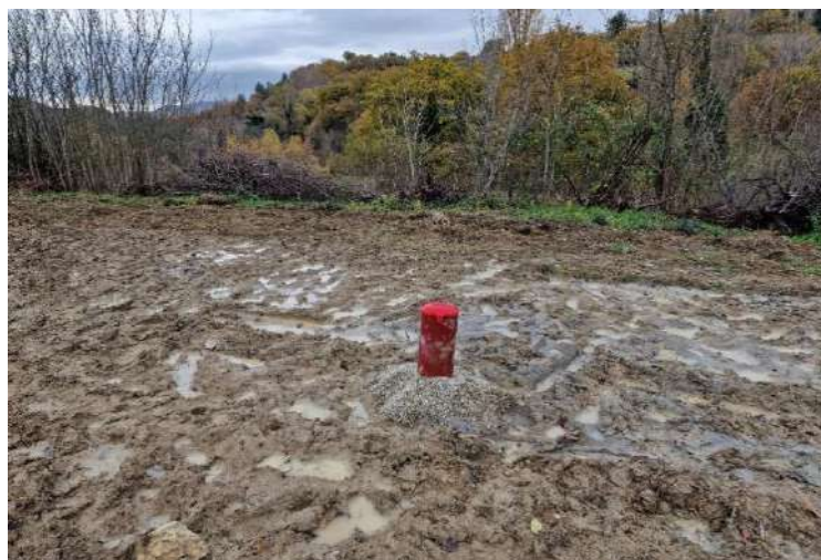
Chiusino fuori terra
