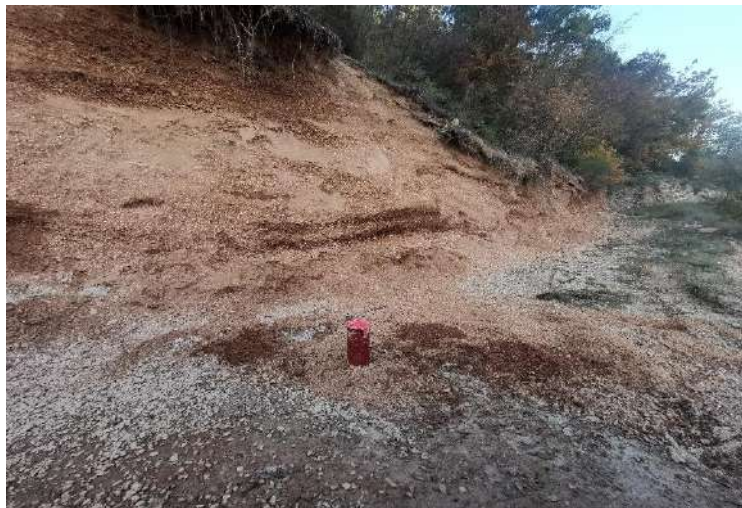
Chiusino fuori terra
