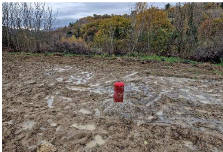
Chiusino fuori terra
