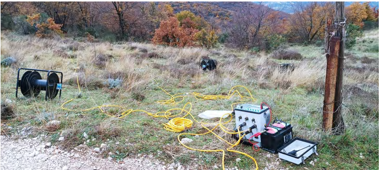
Fig. 10.3 – Foto del profilo ERT2 di tomografia elettrica di resistività.
