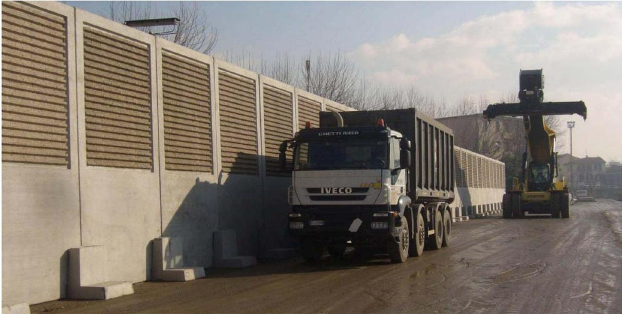
Figura 33: immagine di esempio di installazione di una barriera mobile
