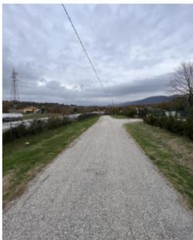
Figura 4 Foto 2 (fonte: sopralluogo)
