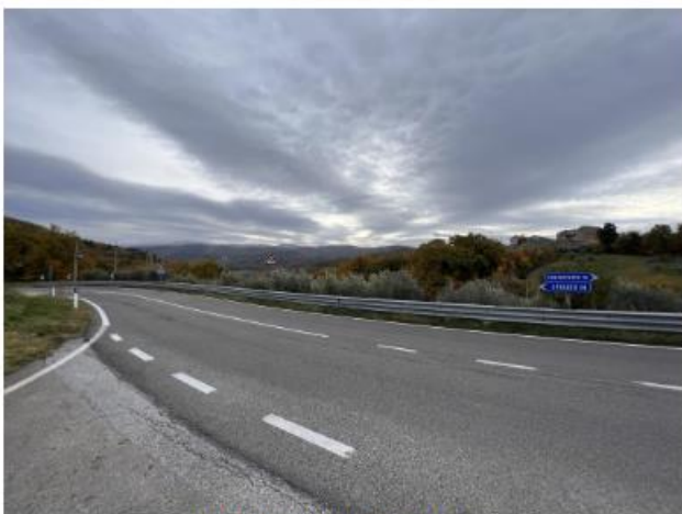
Figura 12 Foto 8 (fonte: sopralluogo)
