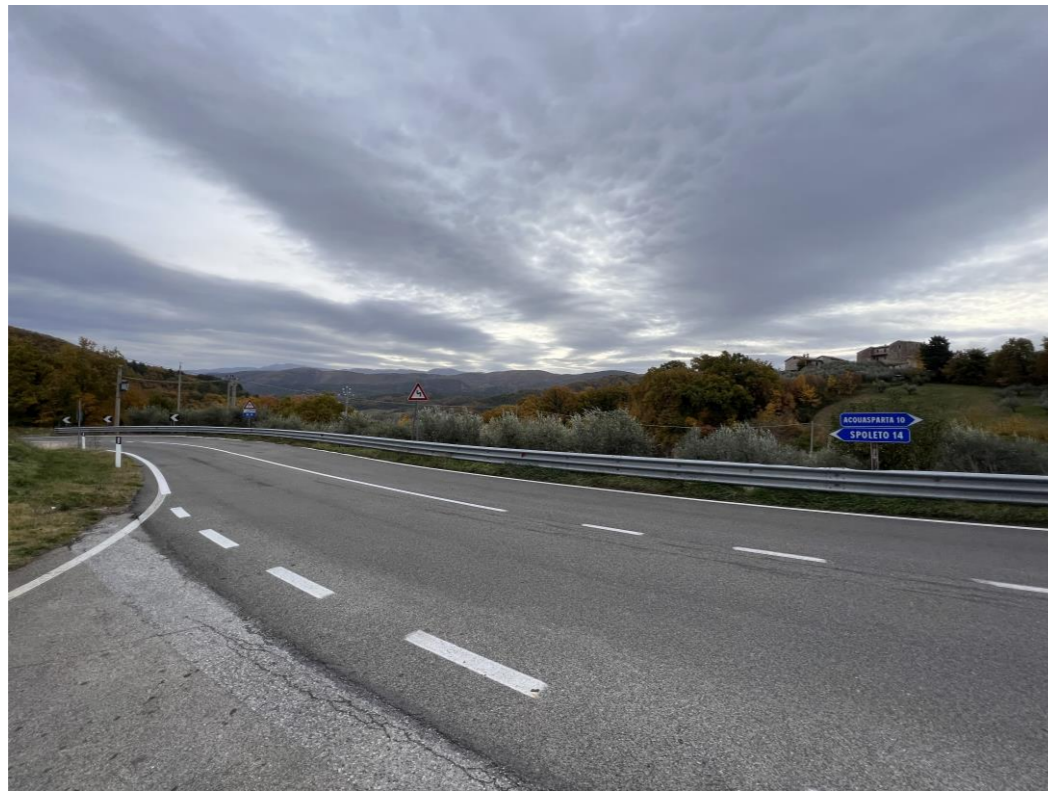
Figura 12 Foto 8 (fonte: sopralluogo)
