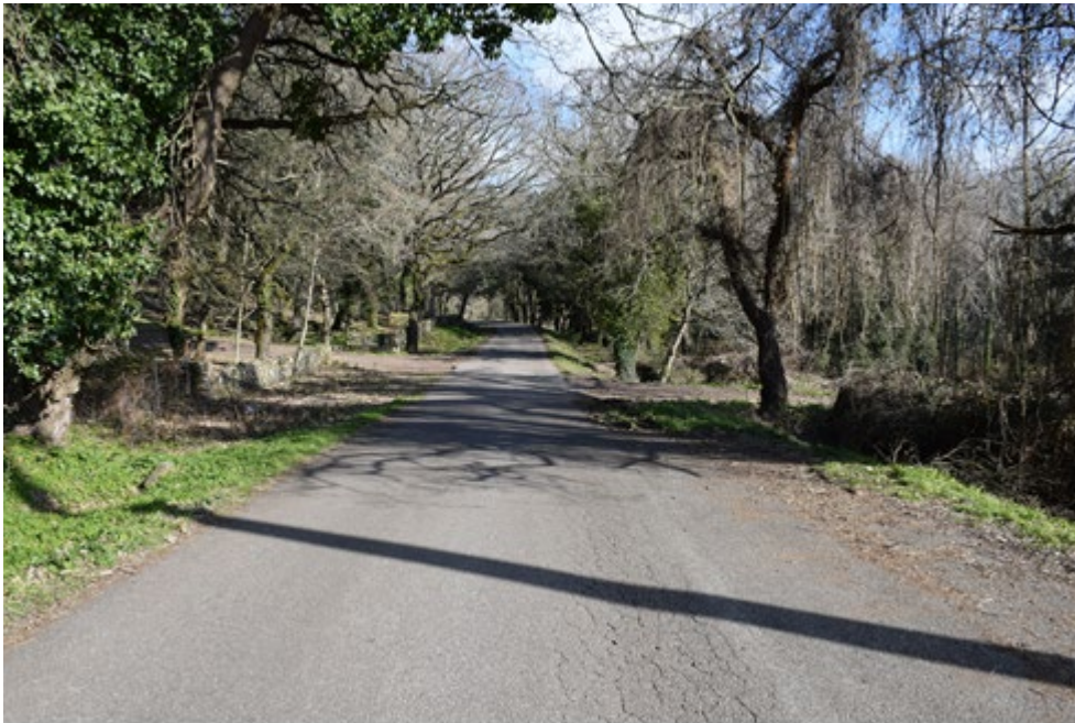
Figura 15: strada comunale nel comune di Macomer alla località S.Antonio in corrispondenza della quale è prevista la posa del cavidotto.
