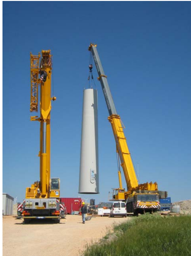
Figura 5: elemento torre smontata da trasportare
