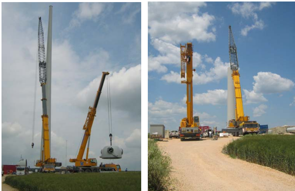
Figura 3: smontaggio navicella
