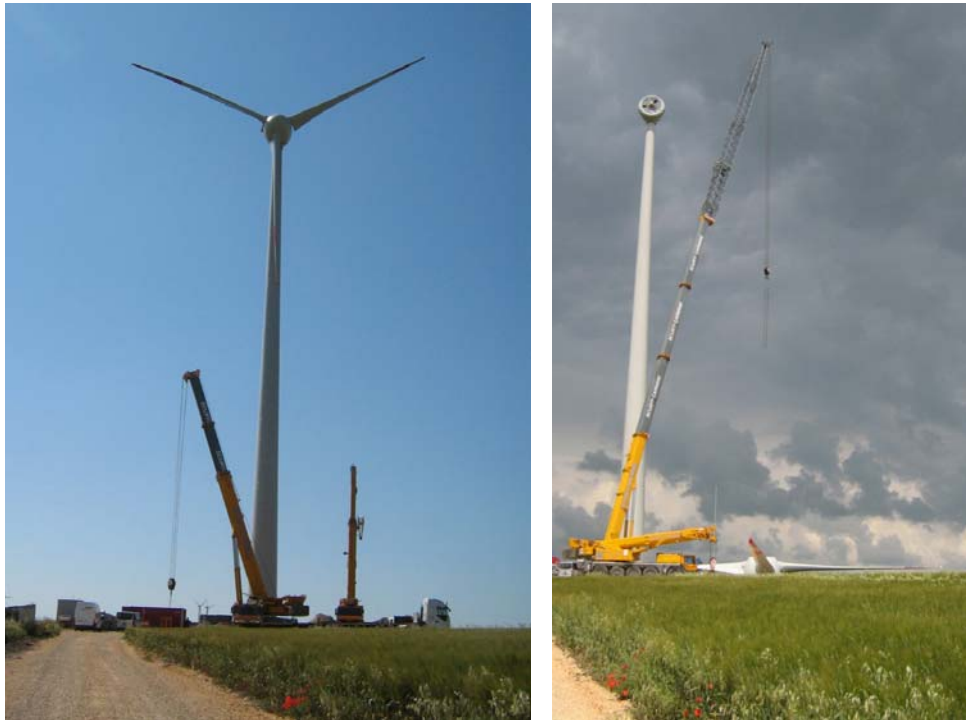
Figura 2: rimozione eliche e mozzo
