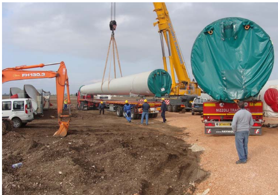
Figura 6: elementi torre smontata da trasportare
