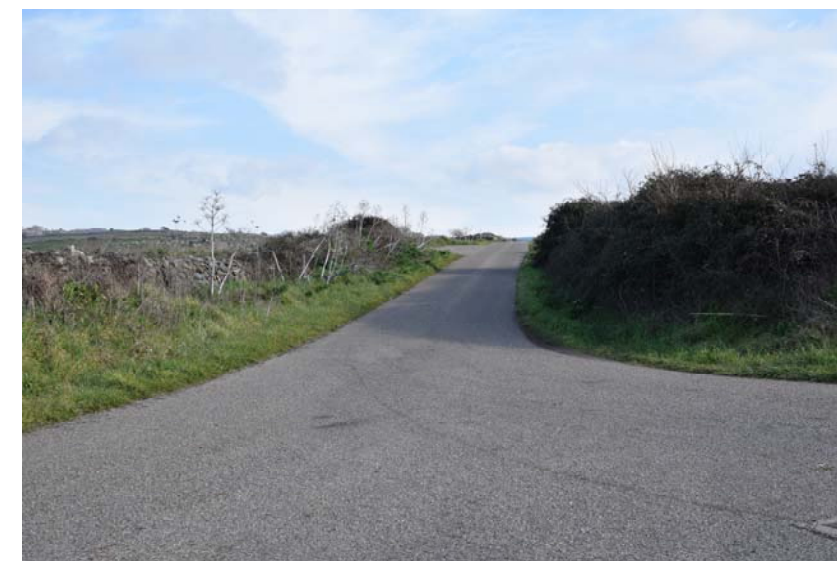
Figura 10: Cavidotto MT in TOC sulla SP63 a superamento dell'alveo torrentizio del Riu Badu Iscanesu
