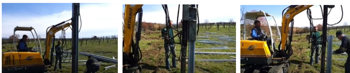
Sequenza fotografica che mostra l'infissione eseguita con battipalo di pali in acciaio ad omega per pannelli fotovoltaici.
