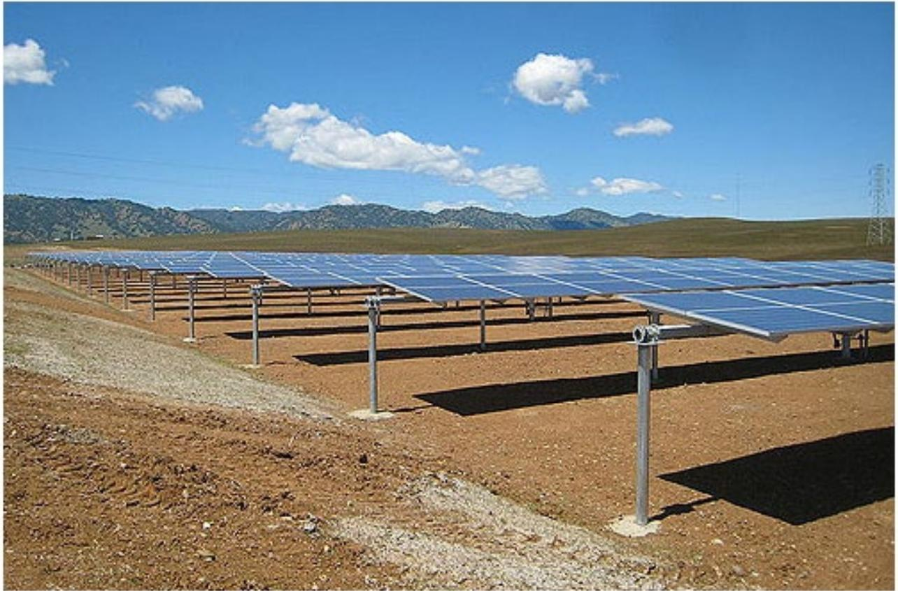
Fig. 33 – Foto tipo trackers monoassiali a inseguimento solare.
