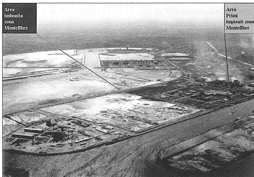
Foto 3: imbonimento dell'area Montefibre
