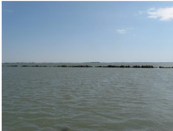
Figura 5.6: Strutture frangiflutti che delimitano il canale Malamocco-Marghera.
