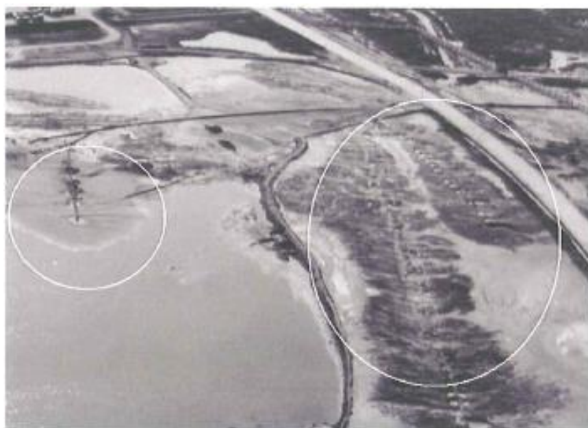
Foto 3: Imbonimento in corso, particolare
