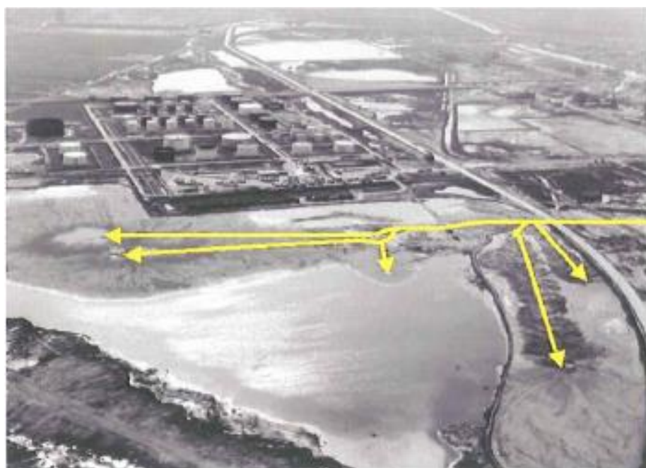
Foto 2: Imbonimento in corso nell’area del nuovo petrolchimico; sono evidenziate (in giallo) le condotte per l’apporto del materiale solidi
