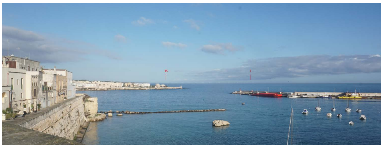
Foto inserimento dell'impianto da terra
