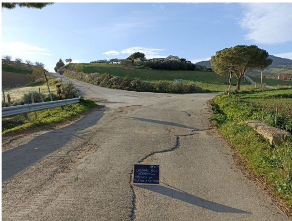
Fig. 38: percorso cavidotto lungo la SP 117
