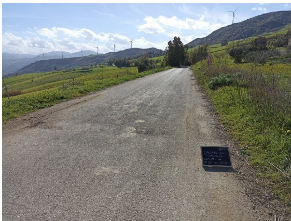
Fig. 36: percorso cavidotto lungo la SP 117
