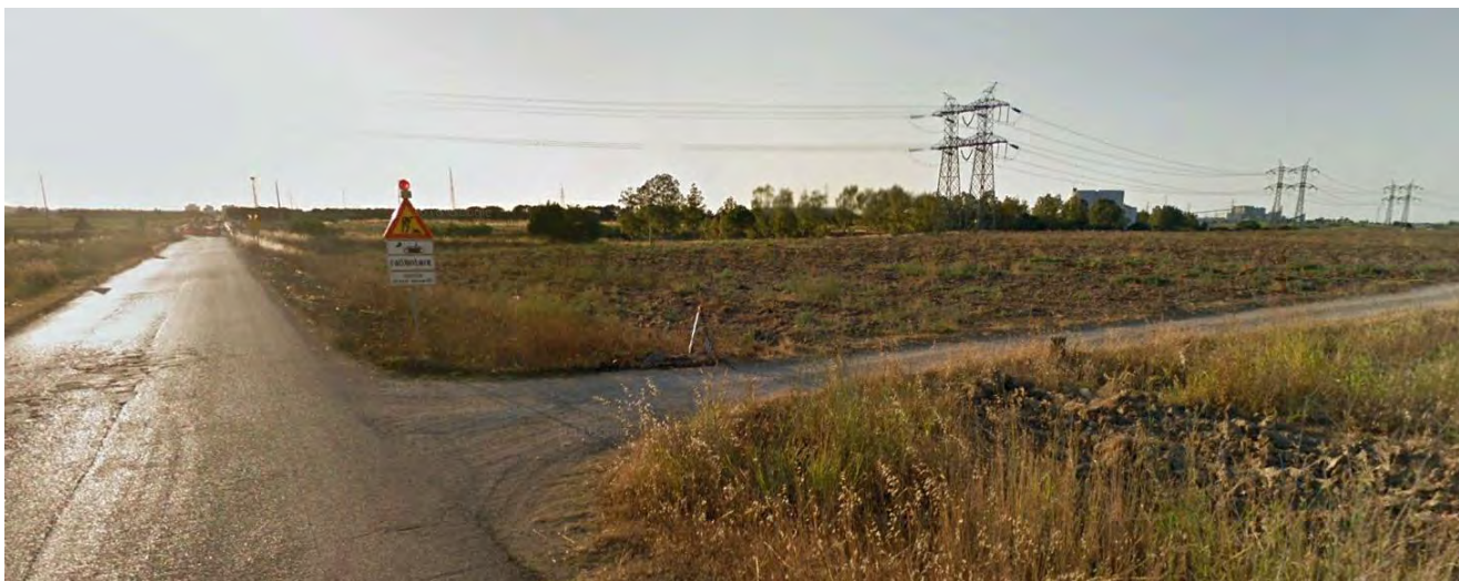
Figura 5-6: SP80 direzione N verso l'area di impianto
