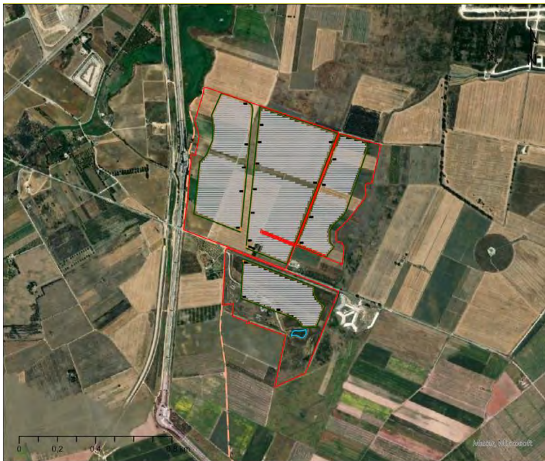
Figura 11: Ortofoto con vista dell'impianto fotovoltaico
