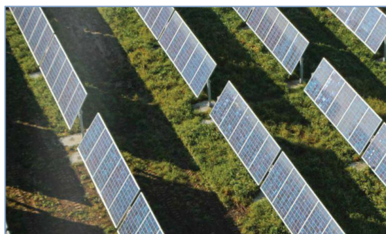
FIGURA 5: FOTO TIPO TRACKERS AD ASSE VARIABILE
