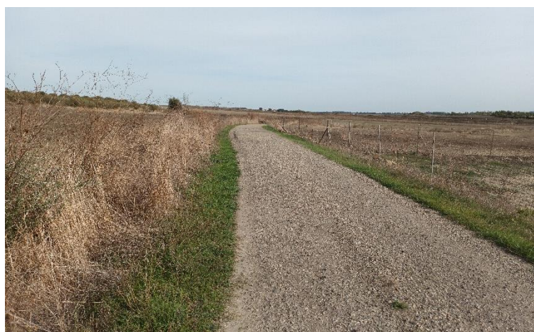
Foto 24 - Viabilità principale verso la WTG9
