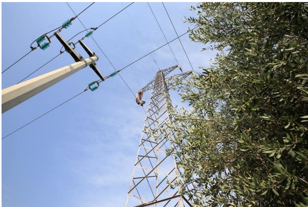
Figura 3-2 Esempio di sostegno tubolare monostelo e traliccio
