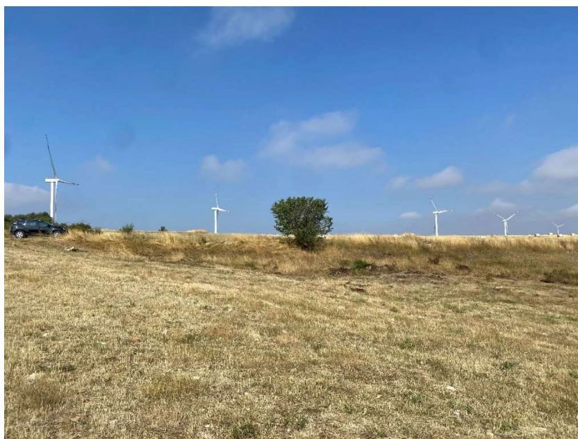
Figura 2 – Area sostegno 01 dell'elettrodotto SE Terna – SSE Vaglio di Ruoti Energia nonché della SSE Vaglio di Ruoti Energia
