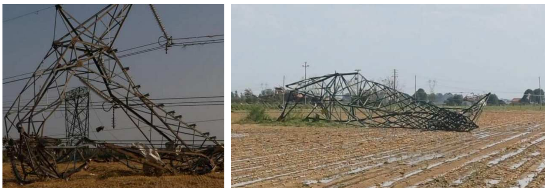
Figura 36. Esempi di tralicci elettrici schiantati al suolo in seguito a forti nubifragi e fortissime raffiche di vento.
