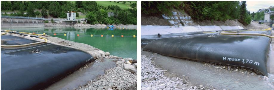
**Figura 20.** Geotubi utilizzati per la disidratazione dei fanghi aspirati dal fondo dell'invaso di Monguelfo in provincia di Bolzano.
