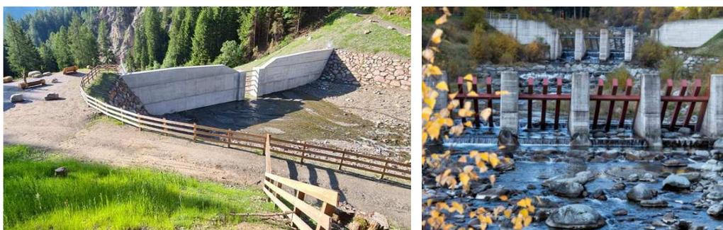
**Figura 17. Esempi di briglie di trattenuta per il materiale solido realizzate in contesti montani, accoppiate a strutture per la trattenuta del materiale flottante.**
