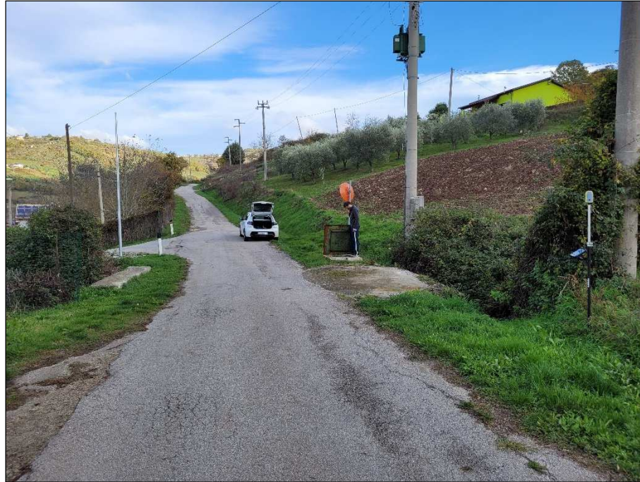
Foto 12 – Attraversamento stradale del corso d'acqua demaniale guardando verso Est.
