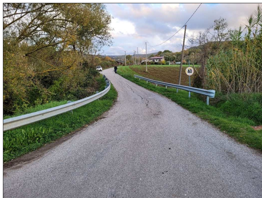
Foto 4 - Vista strada pubblica attraversamento. Vista verso est.
