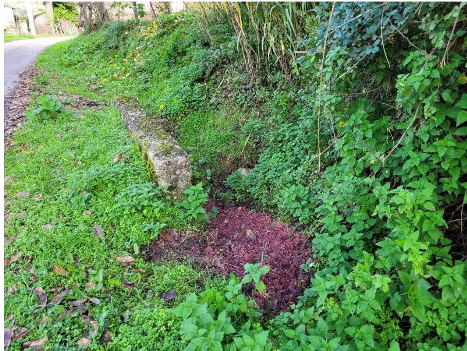
Foto 16 – Veduta dell'alveo del corso d'acqua demaniale a monte dell'attraversamento stradale, che risulta ostruito da materiale depositato e vegetazione.
