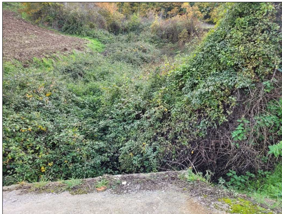
Foto 13 – Veduta dell'alveo del corso d'acqua demaniale guardando verso monte.
