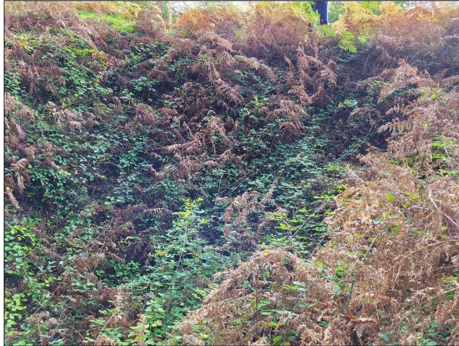
Foto 24 – Veduta dell'alveo del corso d'acqua demaniale a valle dell'attraversamento stradale.
