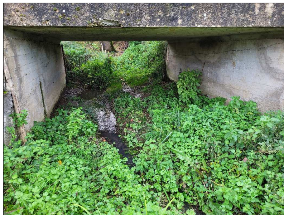
Foto 10 - Veduta dell'alveo del corso d'acqua sotto il ponte di via Contrada Croce.
