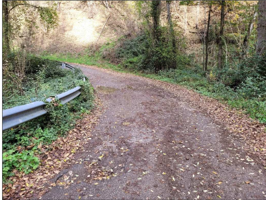
Foto 21 – Visa dell'attraversamento stradale in curva del corso d'acqua demaniale guardando verso Est.
