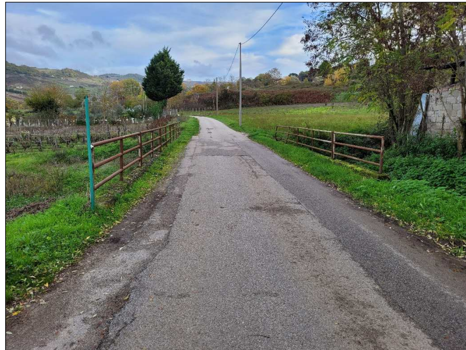
Foto 9 - Vista di via Contrada Croce nel punto di attraversamento del corso d'acqua demaniale, guardando verso Est.
