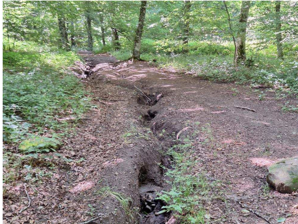
Foto 46 – Strada forestale in erosione, alveo in divagazione.
