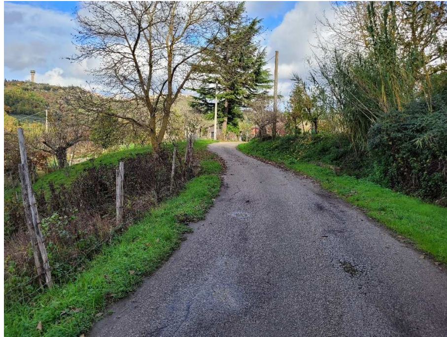
Foto 15 - Attraversamento stradale del corso d'acqua demaniale guardando verso Est.
