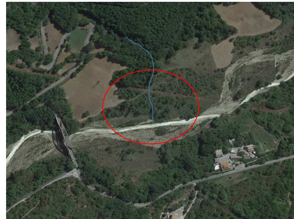
Foto 51 - Estratto vista aerea guardando verso Sud-Est (fonte: GoogleEarth).
