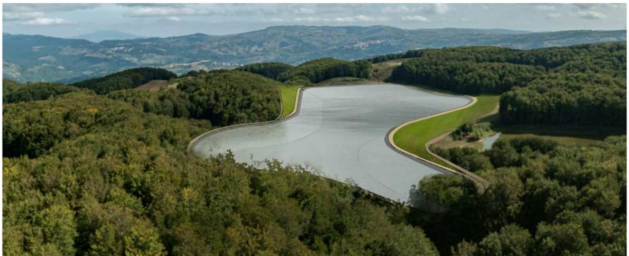
**Figura 154.** Rendering dello stato di progetto del bacino di monte visto dal recettore M. Si notano le arginature dell'invaso realizzate con pendenze dolci e rinverdite.
