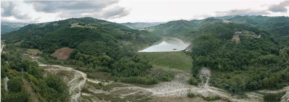
**Figura 157.** Stato di progetto dell'invaso di valle con le opere annesse (vista dal recettore I). La centrale non si percepisce grazie alle misure di mitigazione previste. il paramento della diga rinverdito presenta pendenze dolci. Lo scarico sarà inserito nel versante esistente e si noterà solamente lo sbocco nella fiumara.
