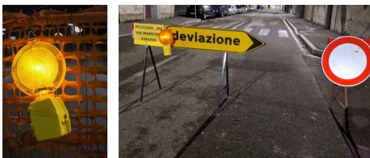
Figura 16. Esempi di illuminazione dei cantieri lineari lungo la viabilità locale nel Comune di Ruoti. Previsti all'occorrenza anche presso i cantieri mobili lungo l'elettrodotto aereo.
