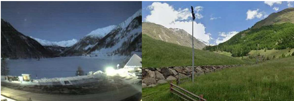
Figura 3. La diga di Vernago in Provincia di Bolzano. Sul coronamento sono presenti dei punti luce, non sono presenti lampioni stradali. I paramenti sono illuminati con appositi fari che vengono accesi solo in caso di necessità.
