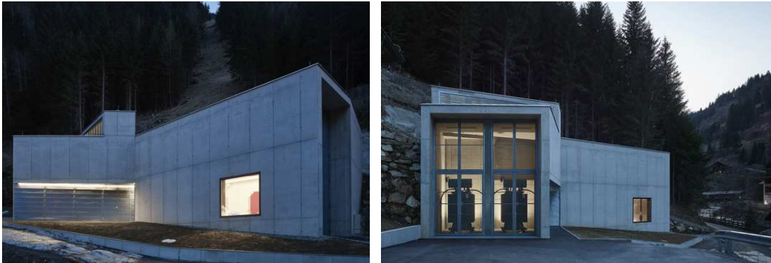
Figura 19. Esempio degli effetti dell'eventuale illuminazione notturna dell'edificio della centrale di produzione.
