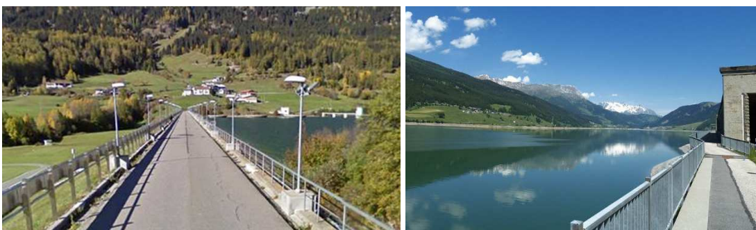
Figura 2. La diga di Resia in Provincia di Bolzano, illuminata di notte con un sistema di lampioni stradali ottimizzati. Si notano i fari direzionati verso i paramenti da azionare in caso di emergenza e/o di ispezione.
