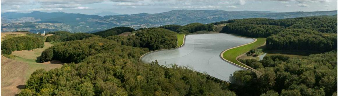
**Figura 59.** Rendering aereo dello stato di progetto del bacino di monte. Si notano le arginature dell'invaso realizzate con pendenze dolci e rinverdite.
