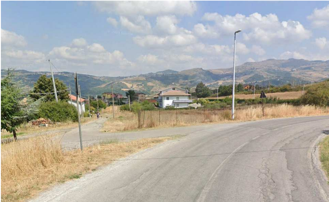
Figura 30. Il cavidotto attraverserà la SP ex SS7 (27).
