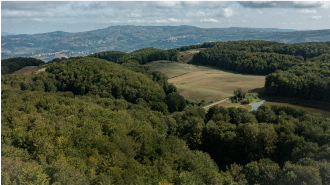
Figura 27. Vista aerea dell'area in cui è prevista la realizzazione del nuovo bacino di monte (24) preservando il lago della Moretta esistente.
