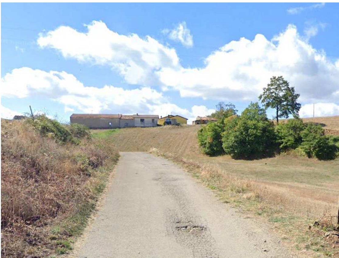
Figura 18. Tratto in cui la condotta forzata sottopassa la strada poderale esistente (15).
