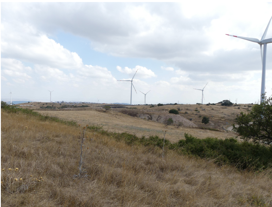
Figura 51. Vista del sito di realizzazione della nuova SSE Consegna Vaglio Ruoti Energia dalle aree collinari limitrofe (48).
