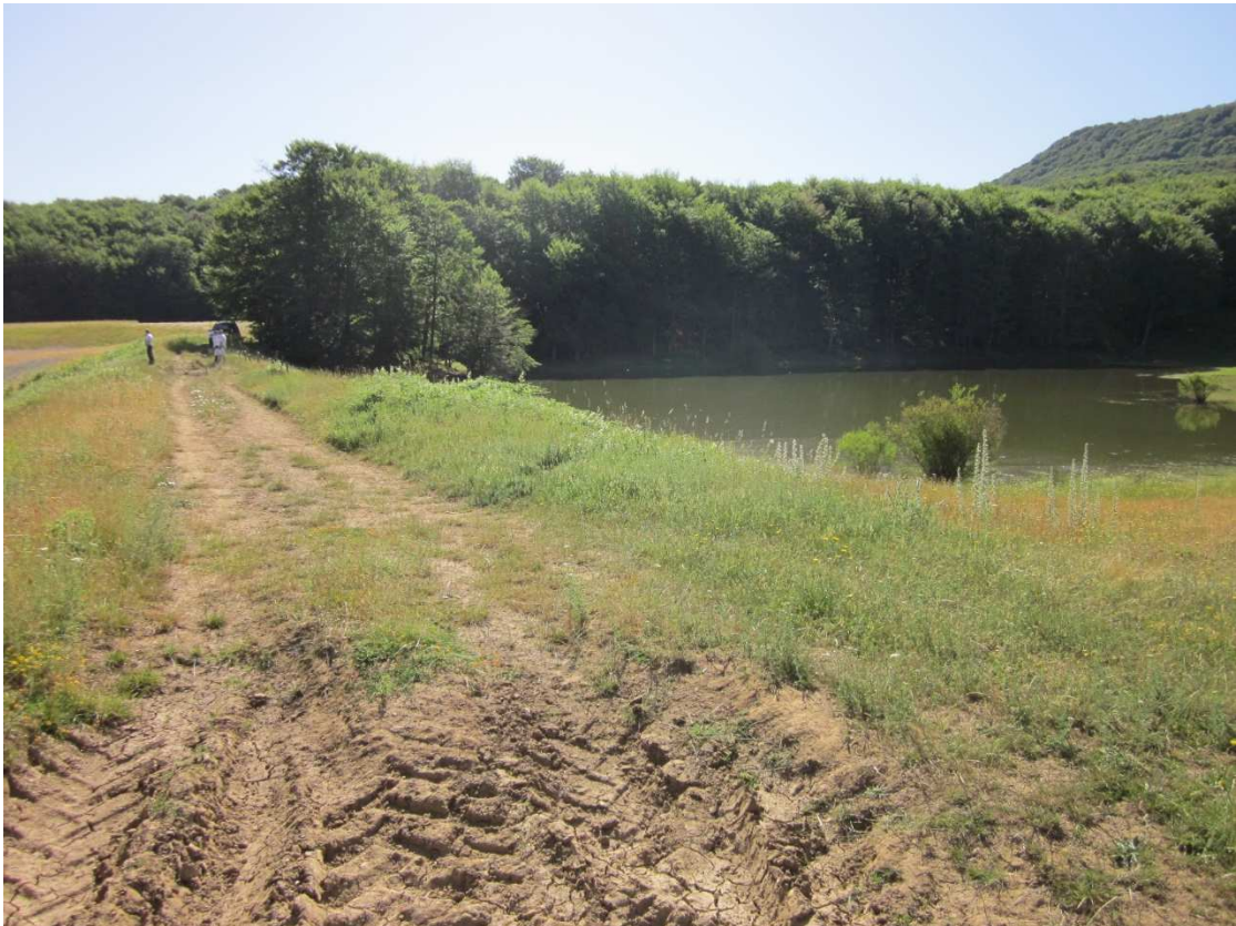
Figura 24. L'argine artificiale che confina l'accumulo delle acque proprio del Lago della Moretta (21).
