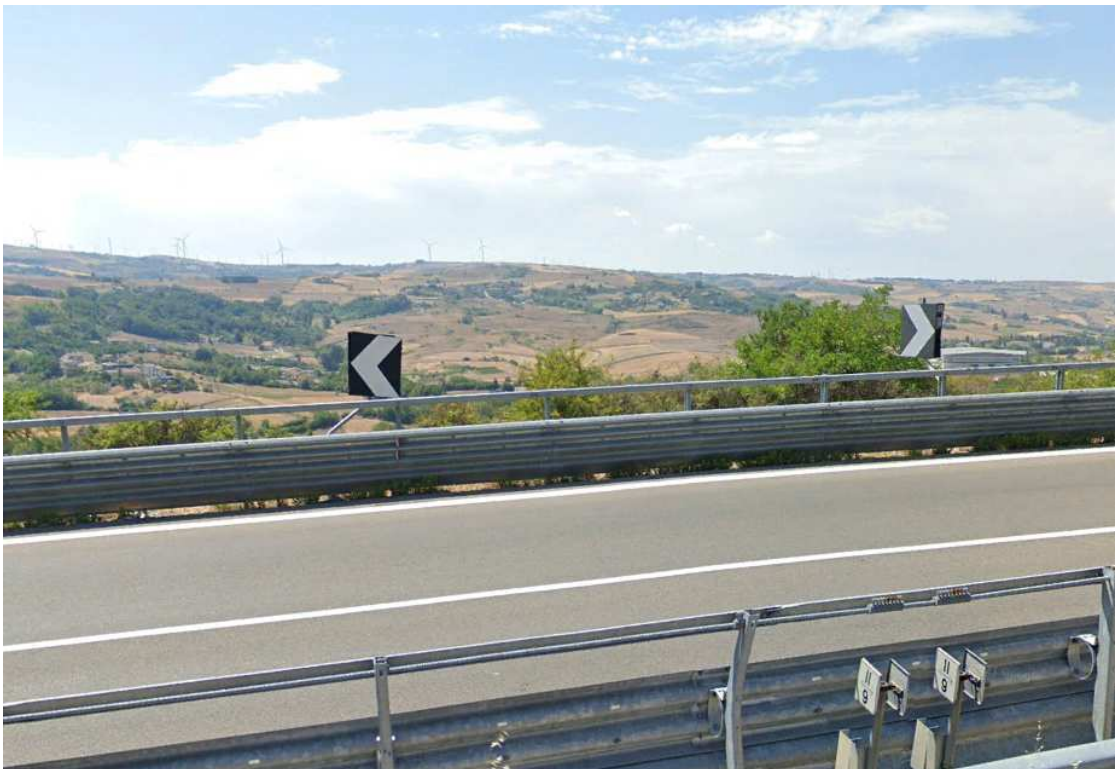
Figura 35. Superamento della SS658 in contrada San Francesco (32).
