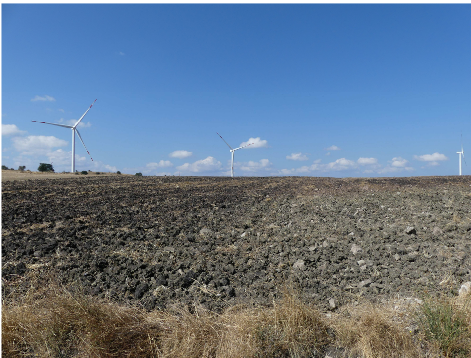
Figura 47. Vista del sito di realizzazione della nuova SSE Consegna Vaglio Ruoti Energia dal tratturo di Cancellara (44).
