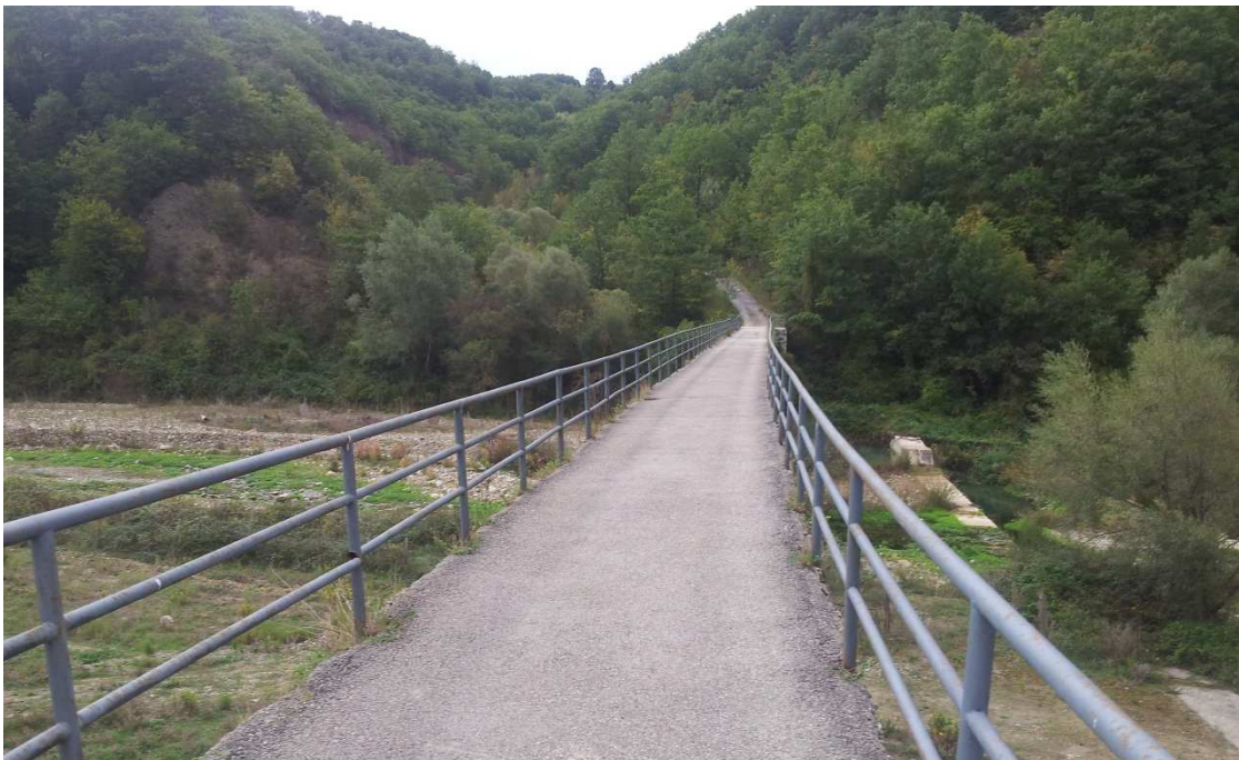
Figura 13. Il ponte stradale sulla Fiumara di Avigliano che verrà utilizzato per l'accesso alla centrale di produzione (10) .
