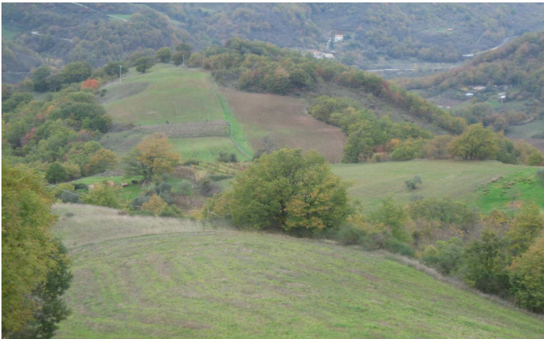
Figura 17. Alcuni dei versanti prativi attraversati dalla condotta forzata, sempre interrata (14).
