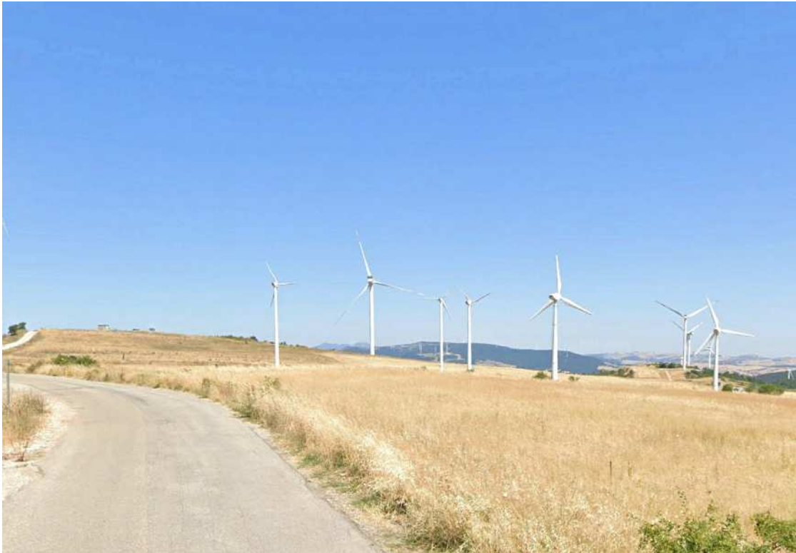
Figura 36. Sito in cui verrà realizzato il traliccio Nr. 8 lungo la SP10 (33).
