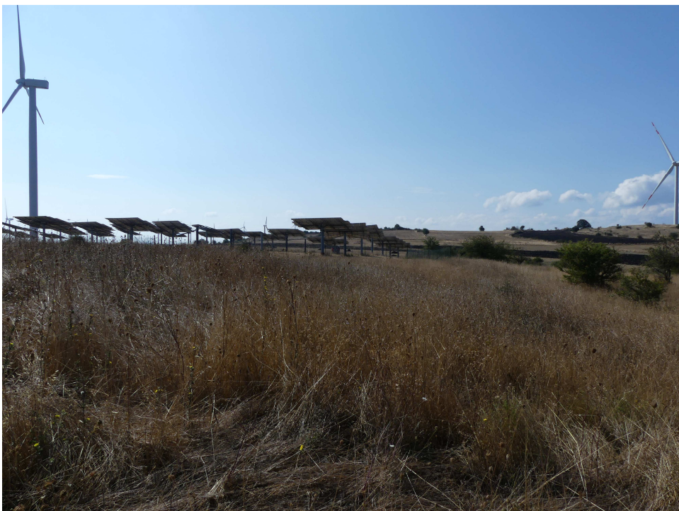
Figura 45. Vista del sito di realizzazione della nuova SSE Consegna Vaglio Ruoti Energia dal tratturo comunale di Occhio Nero (42).
