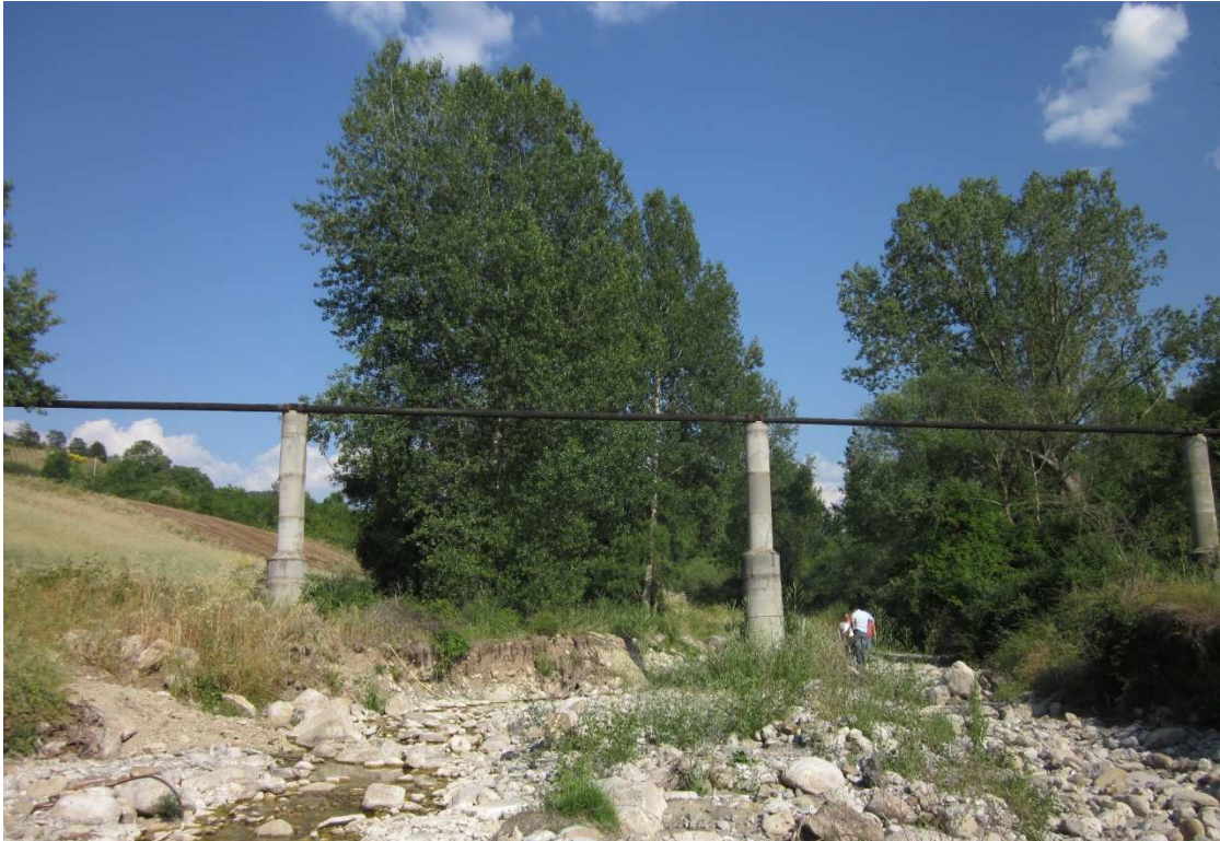
Figura 4. La Fiumara di Ruoti all'apice del nuovo invaso di valle (1).
