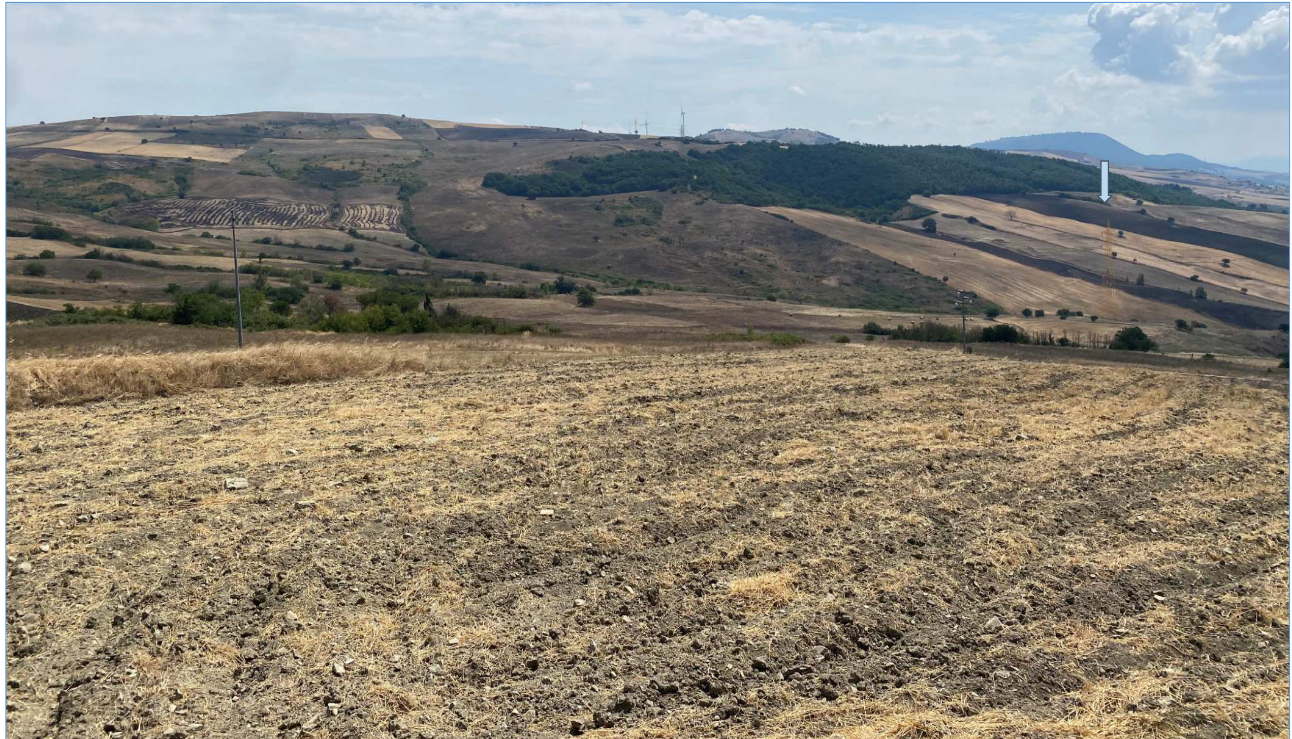
Figura 23. Dal recettore Q è percepibile il passaggio dell'elettrodotto aereo. Per ridurre al minimo l'impatto, i tralicci avranno colorazione idonea e coerente con il contesto paesaggistico locale ed inoltre si procederà ad una piantumazione di filari alberati autoctoni in prossimità delle (poche) abitazioni, masserie e aziende agricole interessate dagli impatti.
