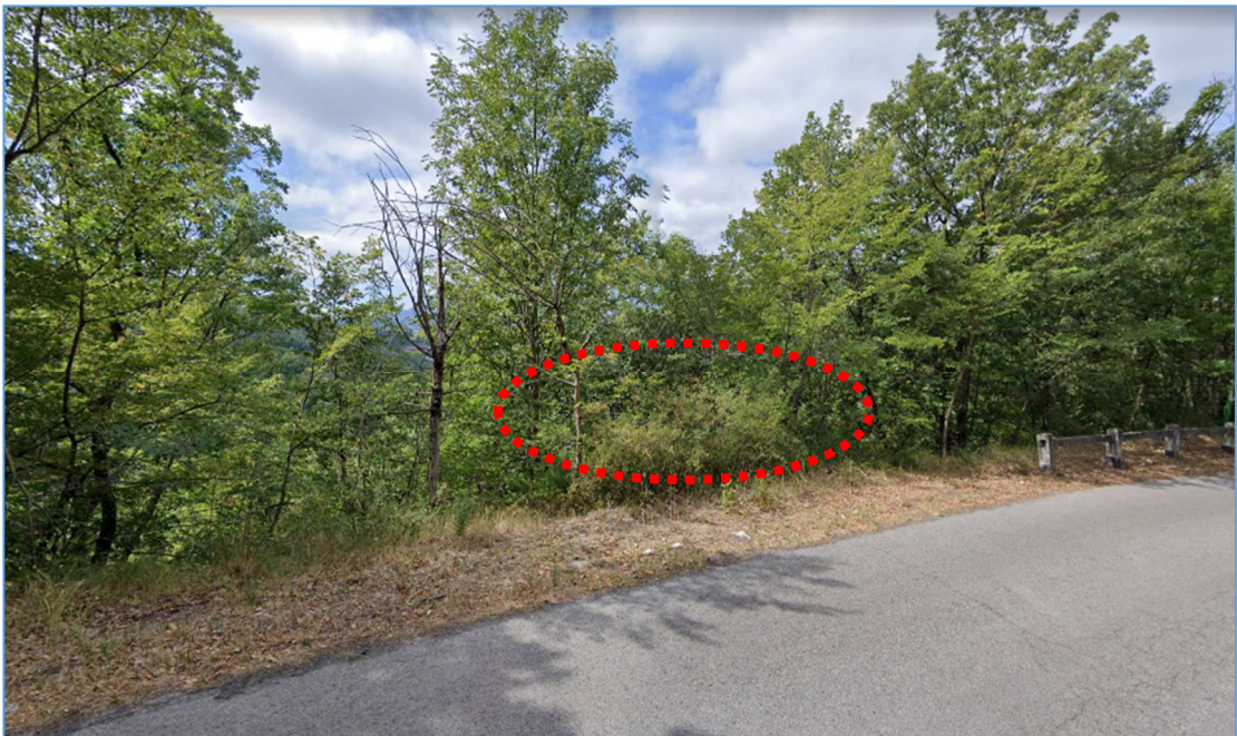
Figura 14. La parte superiore dell'edificio della centrale è fuori terra ma la percezione della sua presenza è molto ridotta. La presenza della diga quasi non si percepisce perché è mascherata dalla vegetazione.
