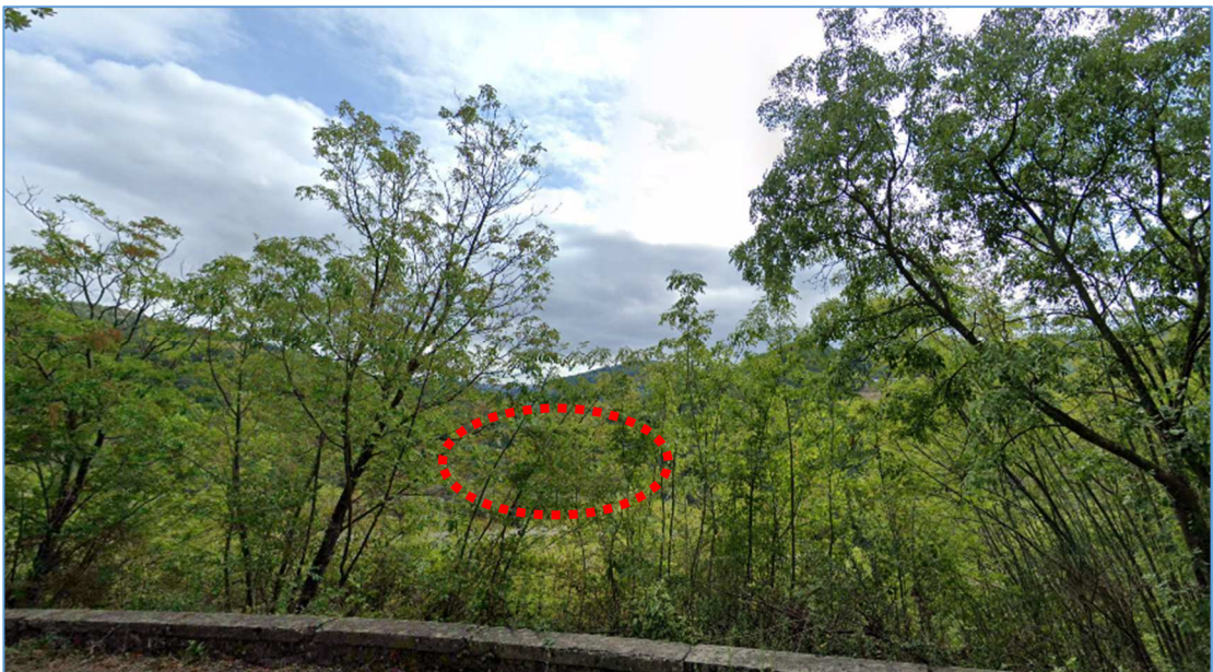
Figura 13. La parte superiore dell'edificio della centrale è fuori terra ma la percezione della sua presenza è molto ridotta. La presenza della diga quasi non si percepisce perché è mascherata dalla vegetazione.
