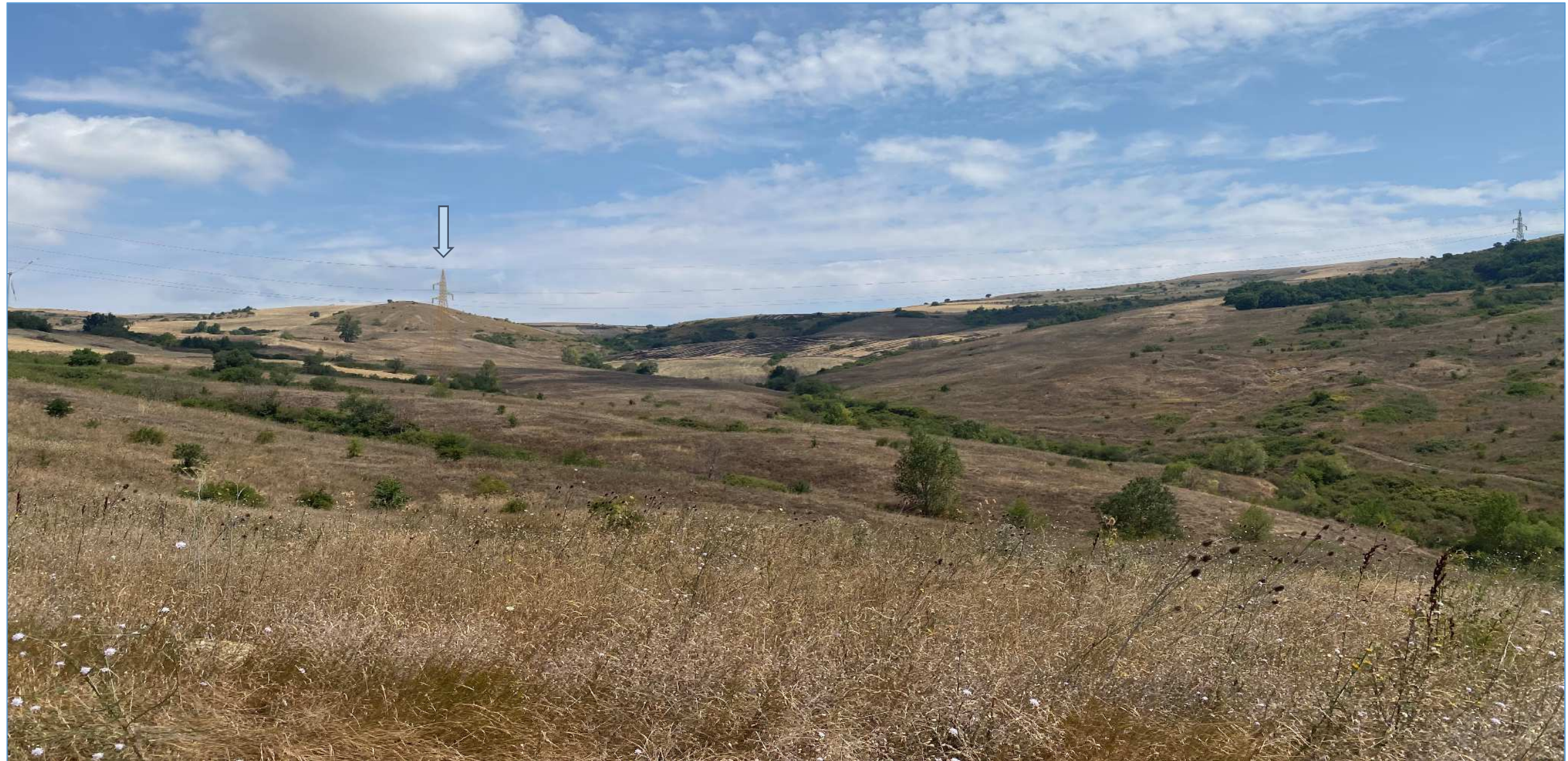
Figura 24. Dal recettore R è percepibile il passaggio dell'elettrodotto aereo. Per ridurre al minimo l'impatto, i tralicci avranno colorazione idonea e coerente con il contesto paesaggistico locale ed inoltre si procederà ad una piantumazione di filari alberati autoctoni in prossimità delle (poche) abitazioni, masserie e aziende agricole interessate dagli impatti.
