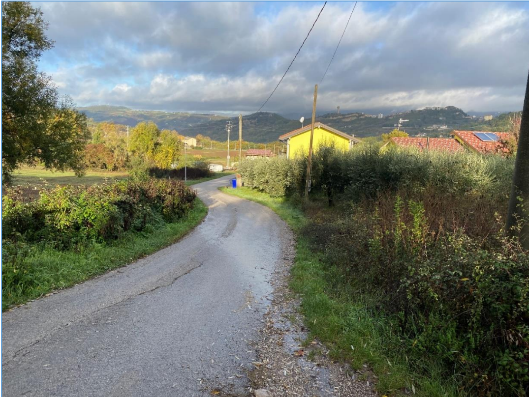
Figura 5 Tratto di sede stradale prima dell'intervento del cavidotto interrato. Dopo gli interventi, verrà ripristinato lo stato dei luoghi come in fase ante-intervento.
