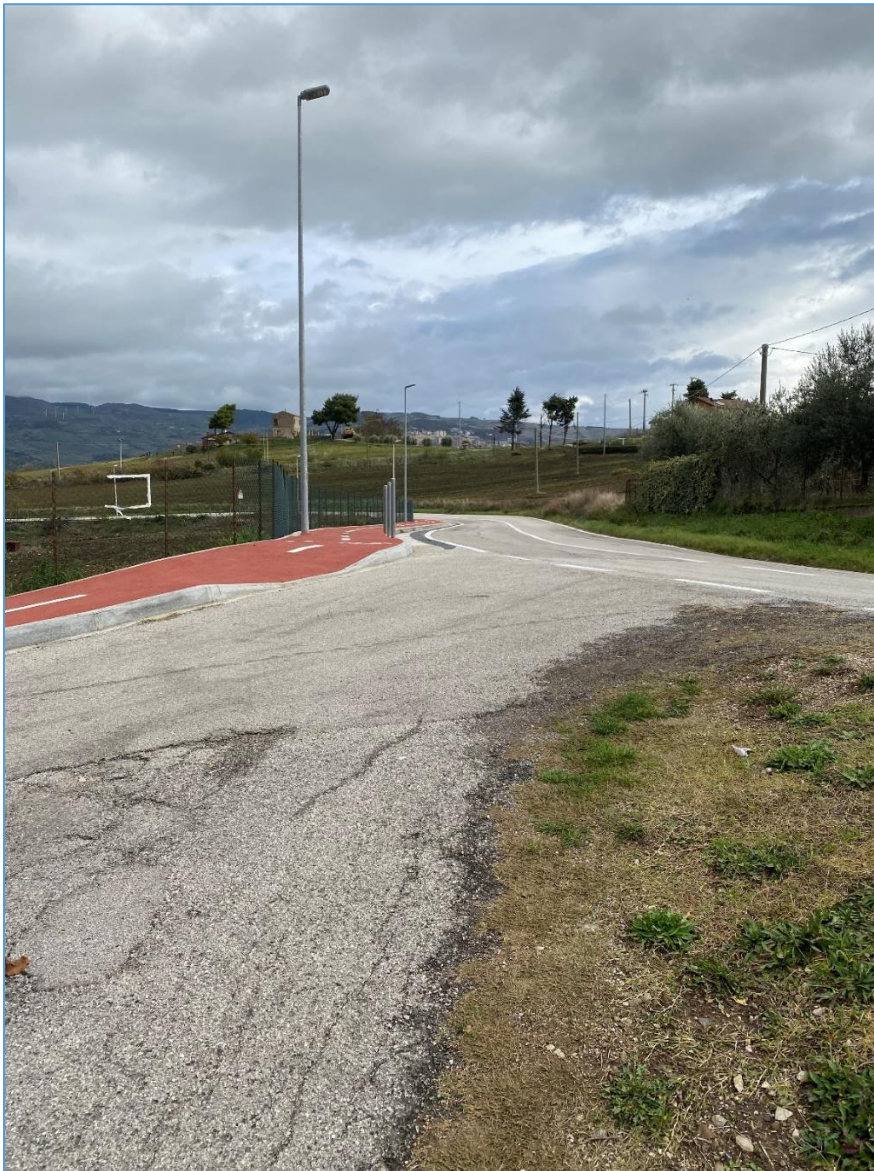
Figura 1 Tratto di sede stradale prima dell'intervento del cavidotto interrato. Dopo gli interventi, verrà ripristinato lo stato dei luoghi come in fase ante-intervento.
