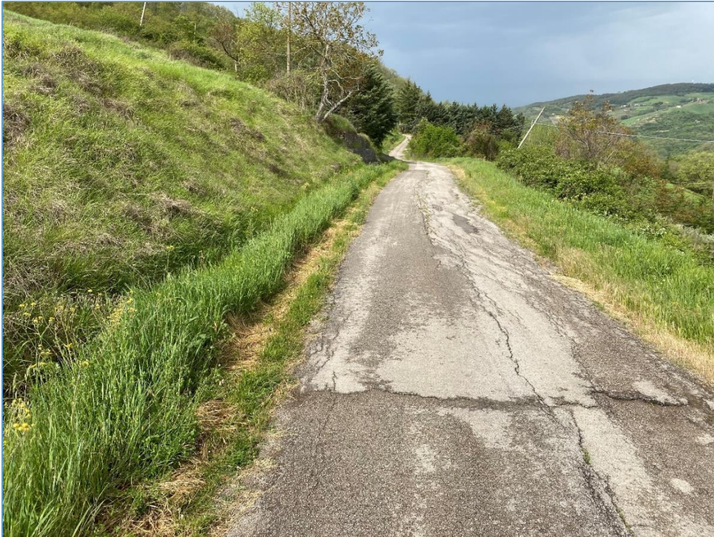
Figura 11 Tratto di sede stradale prima dell'intervento del cavidotto interrato. Dopo gli interventi, verrà ripristinato lo stato dei luoghi come in fase ante-intervento.
