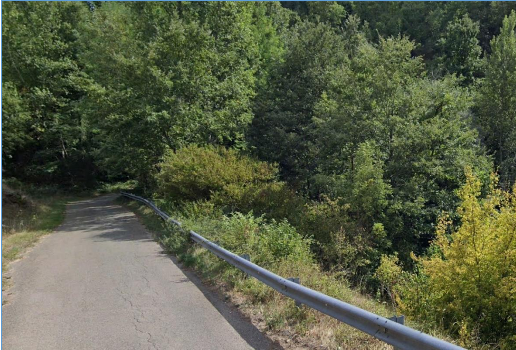
Figura 13 Tratto di sede stradale prima dell'intervento del cavidotto interrato. Dopo gli interventi, verrà ripristinato lo stato dei luoghi come in fase ante-intervento.
