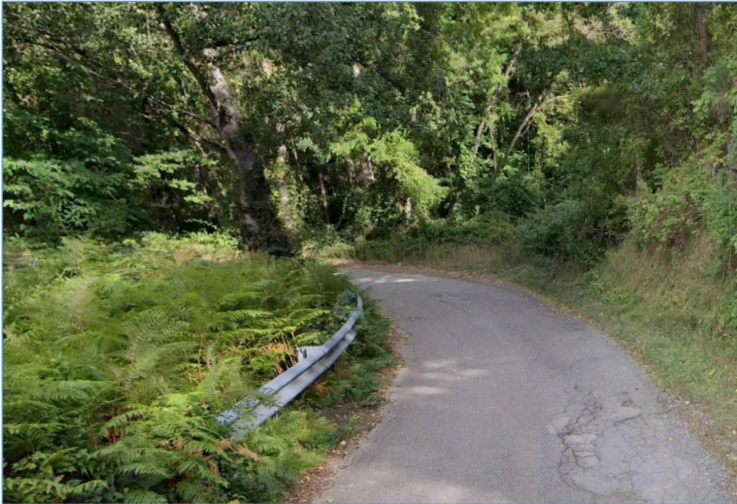
Figura 14 Tratto di sede stradale prima dell'intervento del cavidotto interrato. Dopo gli interventi, verrà ripristinato lo stato dei luoghi come in fase ante-intervento.
