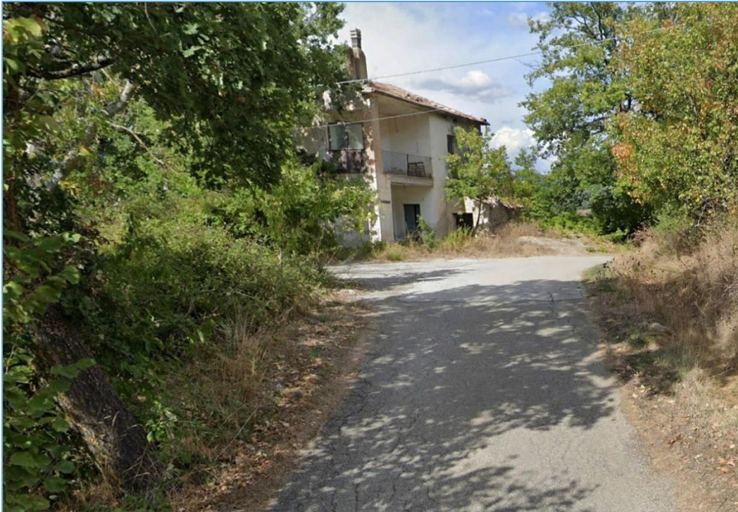
Figura 15 Tratto di sede stradale prima dell'intervento del cavidotto interrato. Dopo gli interventi, verrà ripristinato lo stato dei luoghi come in fase ante-intervento.
