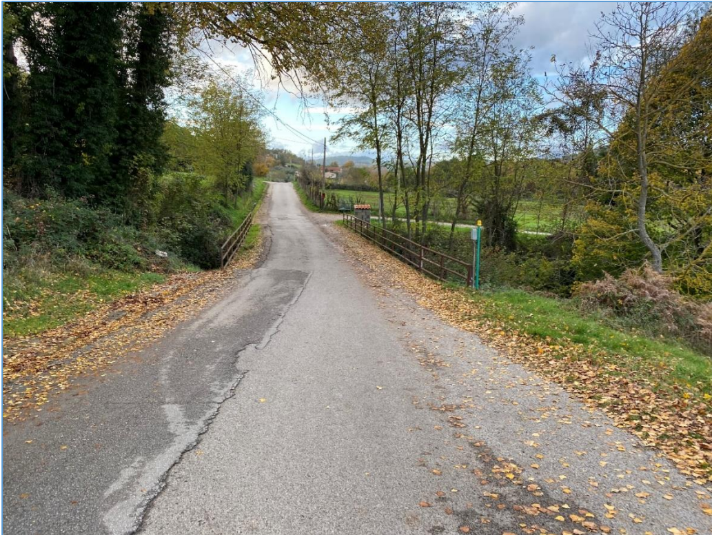
Figura 8 Tratto di sede stradale prima dell'intervento del cavidotto interrato. Dopo gli interventi, verrà ripristinato lo stato dei luoghi come in fase ante-intervento.
