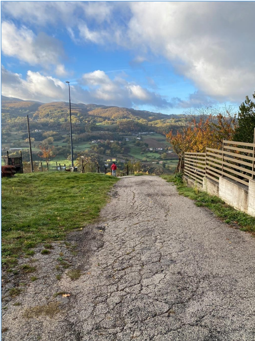
Figura 3 Tratto di sede stradale prima dell'intervento del cavidotto interrato. Dopo gli interventi, verrà ripristinato lo stato dei luoghi come in fase ante-intervento.
