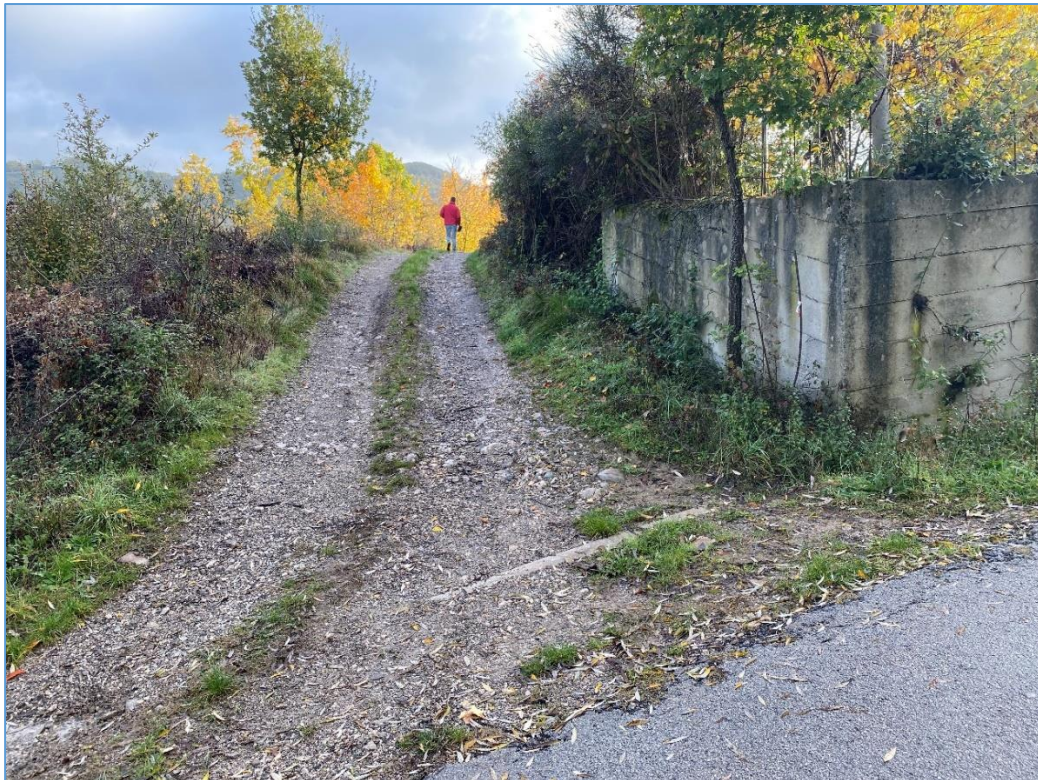
Figura 6 Tratto di sede stradale prima dell'intervento del cavidotto interrato. Dopo gli interventi, verrà ripristinato lo stato dei luoghi come in fase ante-intervento.
